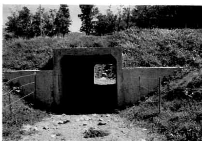
第12図 牛を移動させるための地 下道
