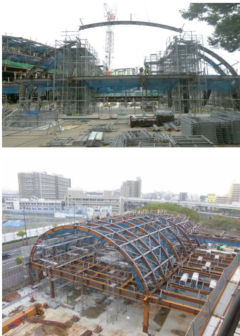
図5. 12 鉄骨建て方
