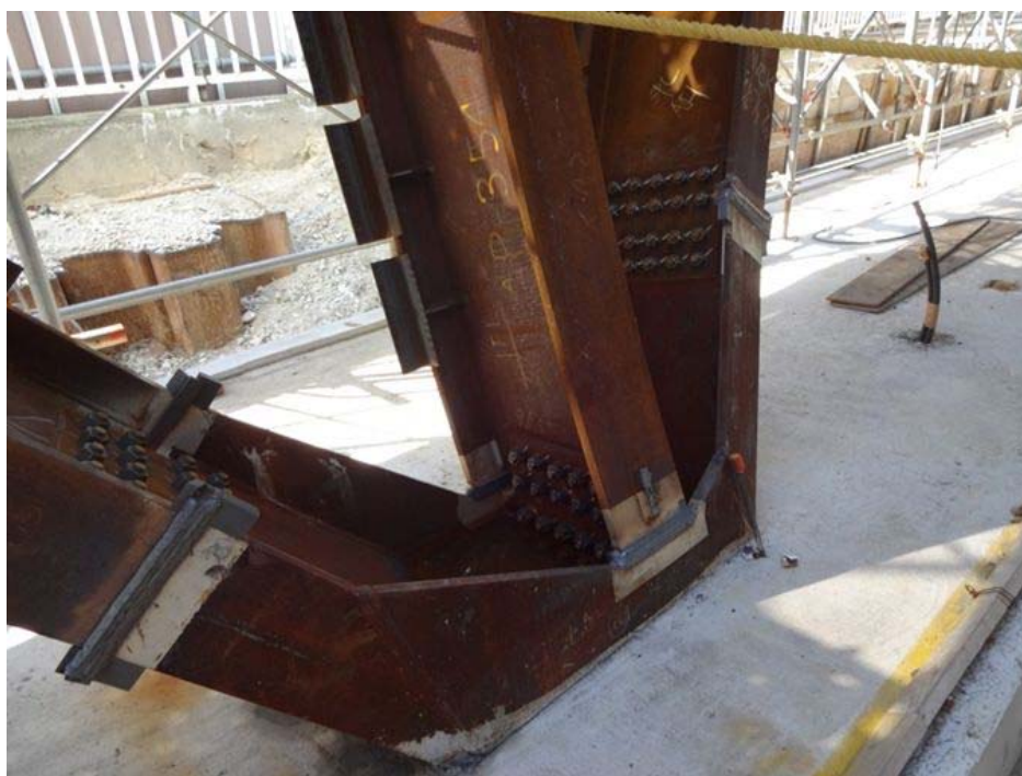
図 5. 13 リングアーチ脚部の納まり
