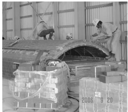
写真3 冷凍焼き芋用オーブン（建設中）
