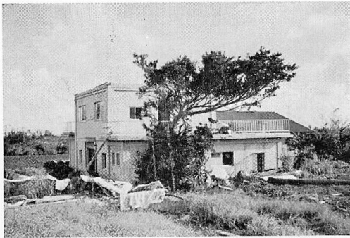
図9 ブロック造住家の屋根被害
