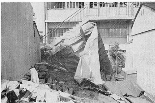
図19 隣地に落下した屋根鉄板
