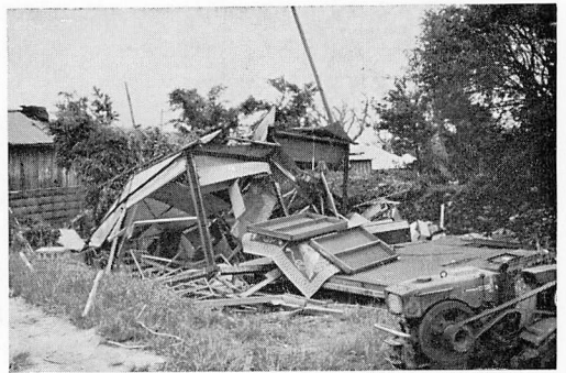
図30 仮設プレハブの倒壊
