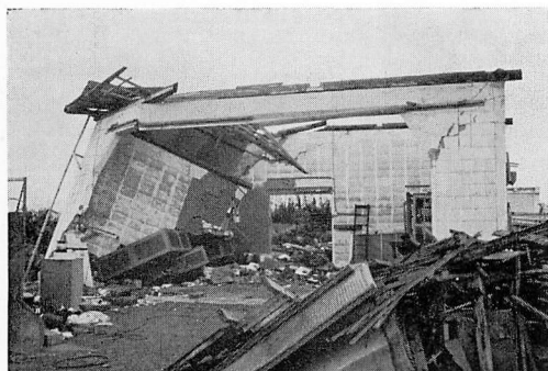
図35 ブロック建物の倒壊
