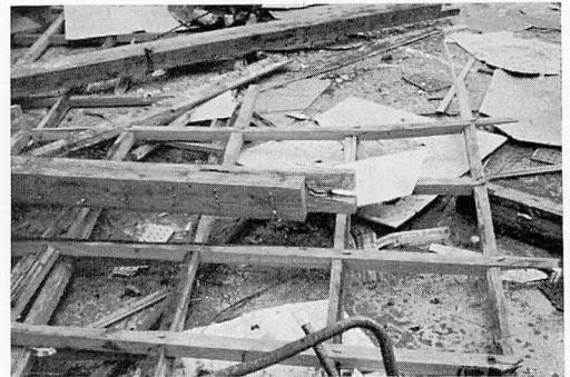
図20 床に落下した母屋と野縁
