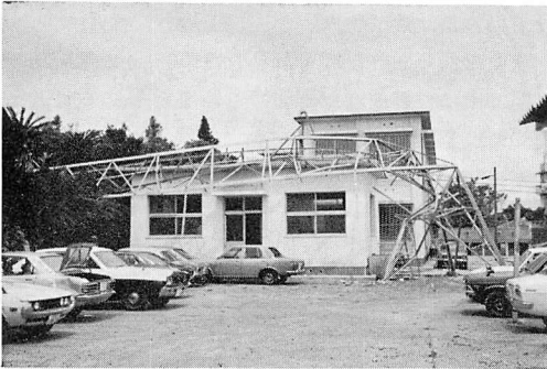
図22 倒壊した無線用鉄塔
