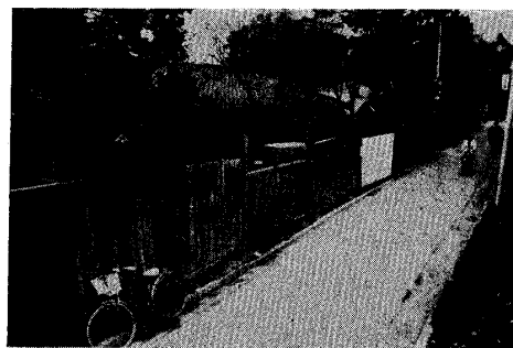
写真-1 A地区の外観
