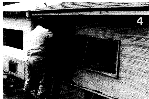
写真2 第2号住宅の建築工程 ①屋根工事 ②屋根材の施工状況 ③壁のモルタル1回目の下塗り作業 ④壁面のモルタル3回目の上塗り作業
