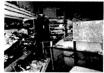
図3-2-2 店舗内部被害状況
