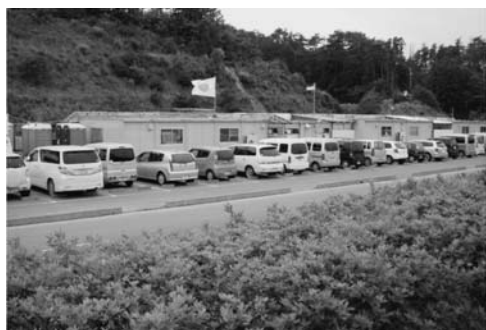
写真20：イスラエルの医師団が造った仮設の病院をそのまま使用（公立志津川病院）
