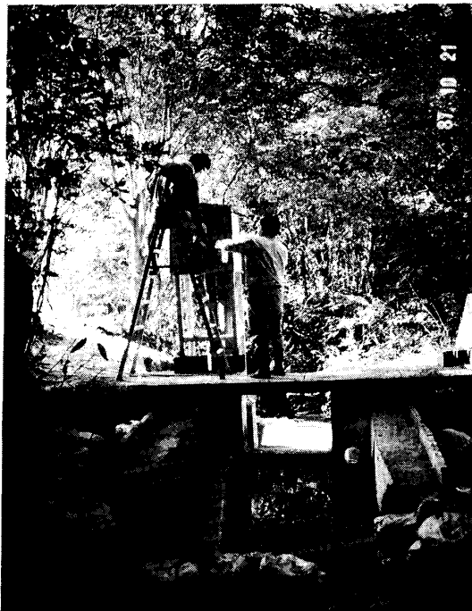
Photo. 3 量水堰堤の完成 (上流側より撮影)
