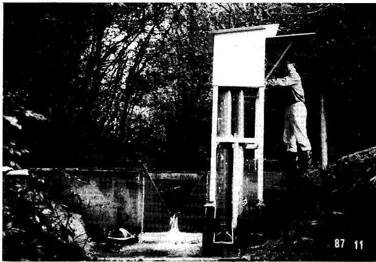
Photo. 7 完成後の量水施設 (下流側より撮影)
