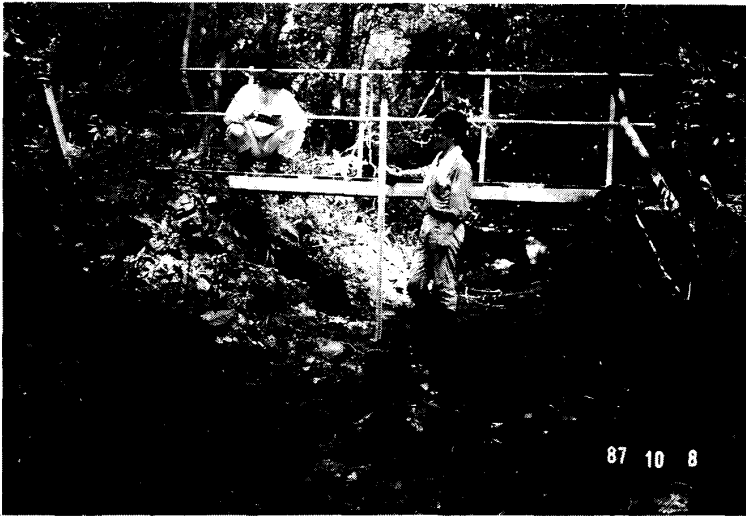
Photo. 1 量水堰堤設置位置の測量 (下流側より撮影)
