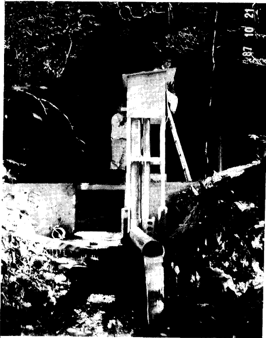
Photo. 4 量水堰堤の完成(下流側より撮影) (堰堤両袖部には排水および排土用として塩化ビニール管を埋設した。また、左岸側の塩化ビニール管は水位観測井戸に通じている。)
