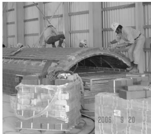
写真3 冷凍焼き芋用オープン（建設中）
