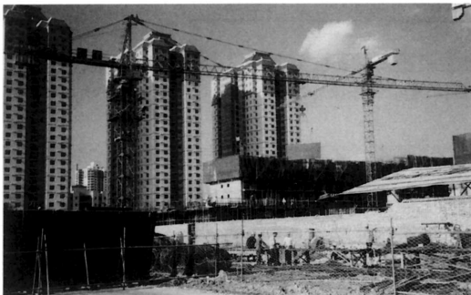
写真1 左：高層ビルの建築ラッシュ（北京市郊外，1999年8月撮影）。右：古い民家の解体と道路拡張工事。古い民家が壊され、そこに高層ビルが建てられている。また道路の拡張工事では鋼管や電線が埋設されている（北京市中心部，1996年10月撮影）。こうした工事は北京市内のあちこちで見られ、鉄、銅などの金属の消費が急増していることを実感させる。
