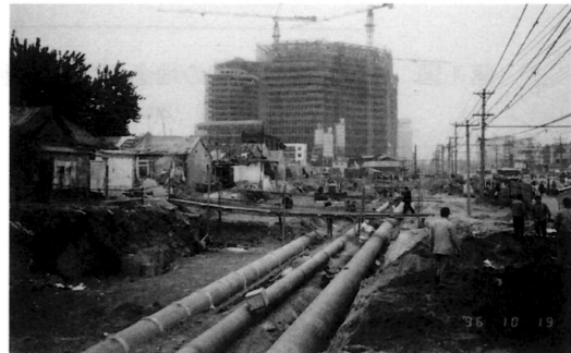
写真1 左：高層ビルの建築ラッシュ（北京市郊外，1999年8月撮影）。右：古い民家の解体と道路拡張工事。古い民家が壊され、そこに高層ビルが建てられている。また道路の拡張工事では鋼管や電線が埋設されている（北京市中心部，1996年10月撮影）。こうした工事は北京市内のあちこちで見られ、鉄、銅などの金属の消費が急増していることを実感させる。
