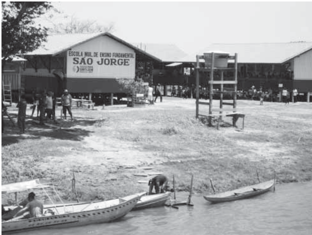
写真15 アマゾン川沿いにある建物のすべてが、洪水を想定して、柱で床を2～3メートル高く持ちあげている。民家と民家間の移動はボートで、子どもたちもボートを器用に操り登校している。
