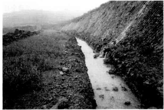
第5図 雨水の排水溝状況。
