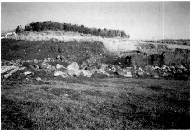
第4図 造成地内の土砂流失防止。
