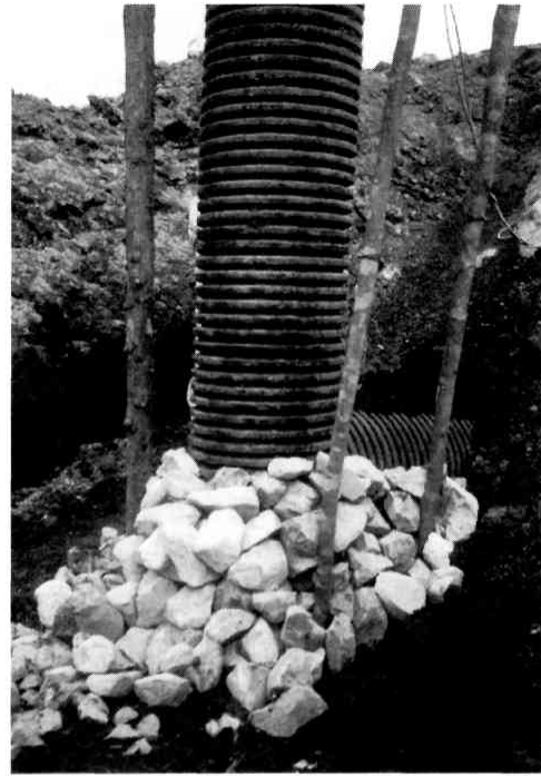
第2図 立溝の設置状況。
