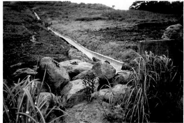
第7図 造成区域外の雨水排水溝の末端部。
