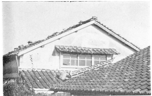
第5図 シックイ詰したケラバ瓦の飛散
