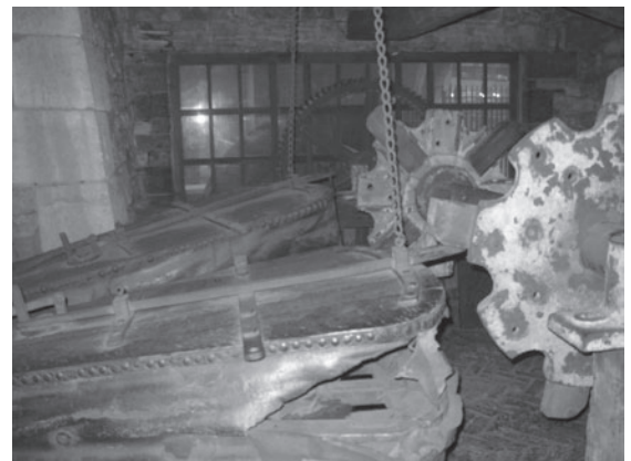
写真 4-2 フイゴ（窓の外に水車）
