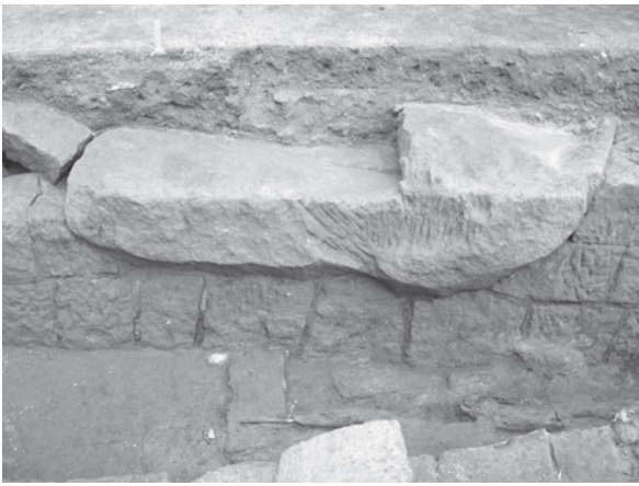
水路跡1 東壁 (A-3・4区) (3次) (西より)
