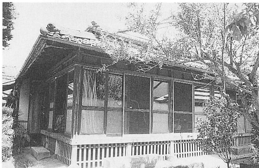
写真-1 宮原家住宅外観
