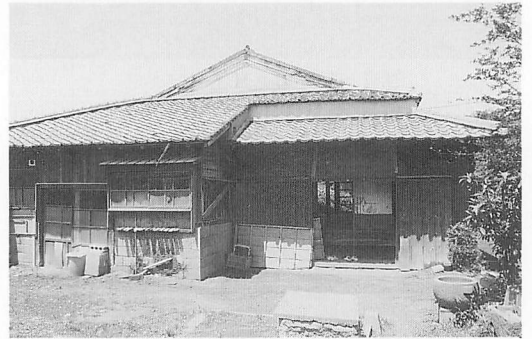
写真-44 三浦家住宅外観
