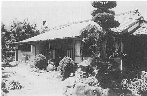
写真-5 大島家住宅外観
