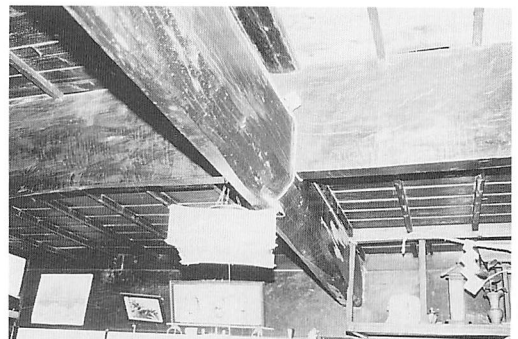
写真-12 指宿家住宅二のおもての天井
