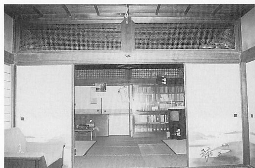
写真-65 楠元家住宅一のおもてから二のおもてを見る
