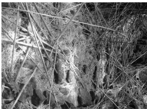
写真9. 集落内の崩れた石垣
