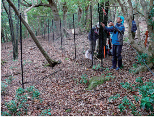
図2. 2 mの高さで下部を2層にした金属網の柵を設置。
