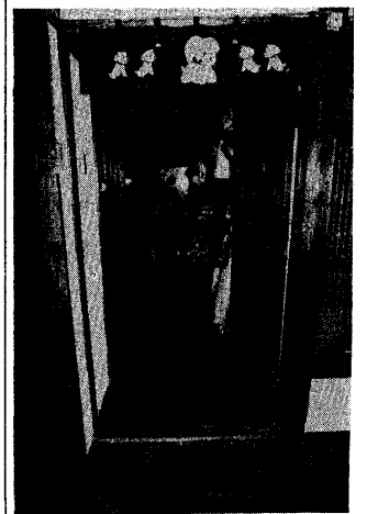
写真-3(図-6) タテ中廊下。つきあたりは合所。
