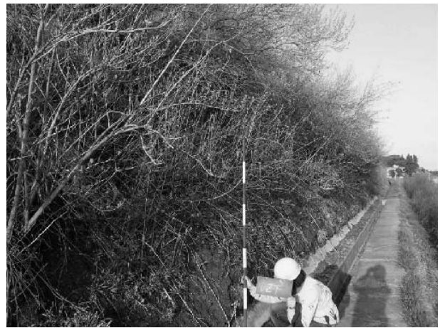
写真-3 D実験区の生育状況 (施工6年3ヶ月後)
