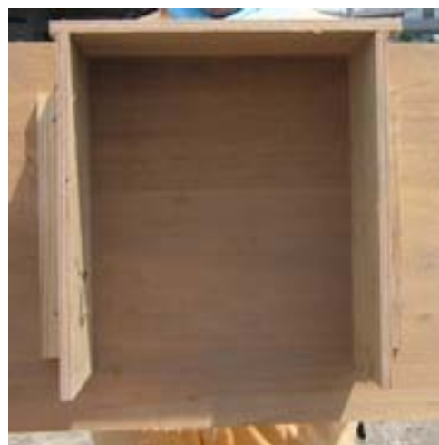
写真-3.2 パネル型枠
