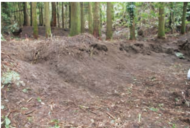
5 Dトレンチ掘削前（北東より）
