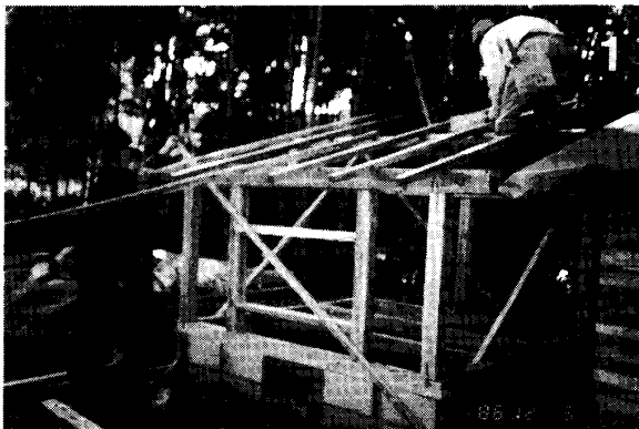
写真1 第1号住宅の建築工程 ①屋根工事 ②屋根材の施工状況 ③壁の下地 ④壁面の防火性外装材の施工状況
