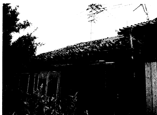
写真-2 屋根瓦の損壊
