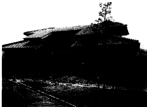
写真-1 一般的瓦屋根の損壊
