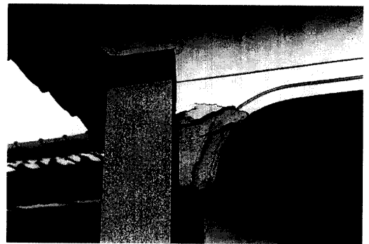
写真-14 突出した玄関の損傷
