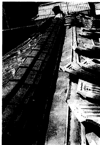
写真-3 屋根瓦(棟)の移動
