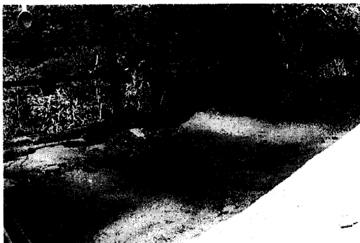
写真-16 宅地法肩部の崩壊と沈下
