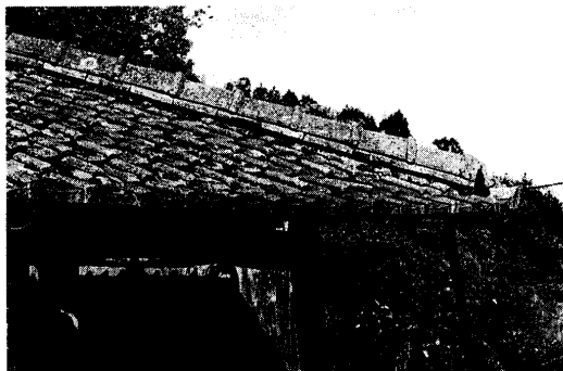
写真-17 宅地法肩部の崩壊による住宅の傾斜
