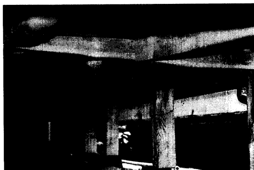
写真-6 床下の構法(束と束石のずれ)
