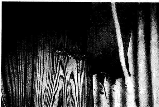
写真-12 鉄骨梁の柱への食い込み
