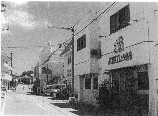
写真1. ギリシアをイメージして作られた白い建物。
