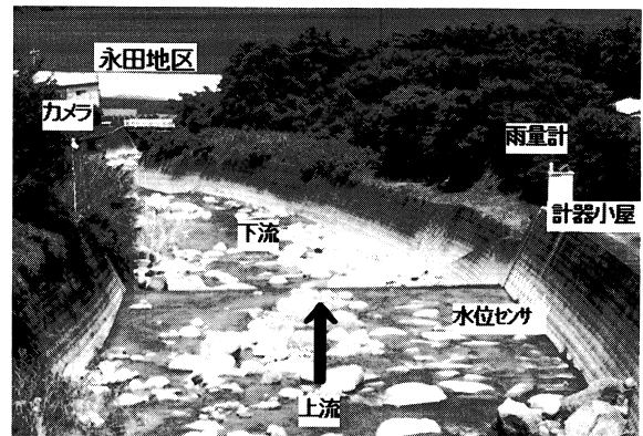
写真-3 土面川水文観測施設 (地頭菌ら, 1992)
