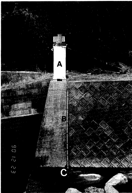
Photo. 2 水圧式水位計の設置状況 A：計器小屋 B：保護管（塩化ビニル管） C：水位検出感部
