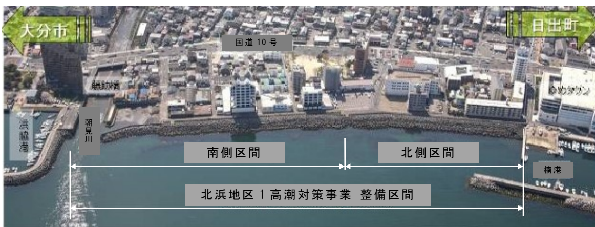
写真 5.1 北浜地区1 護岸の全景
