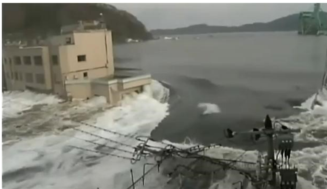
写真 1.1 東北地方太平洋沖地震による構造物周辺の津波の流況 (釜石市民撮影動画より： https://goo.gl/3fYJnY )
