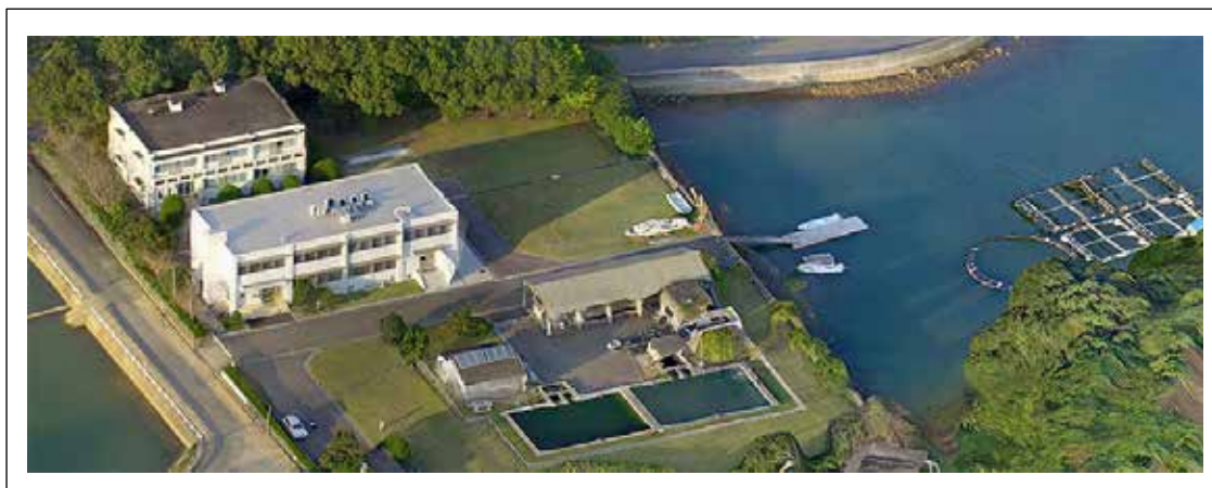
写真-1 改修工事が済み更なる地域貢献が期待される東町ステーション
