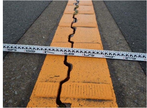
写真 6.17 橋軸方向伸縮装置(1期施工と2期施工の継目部)
