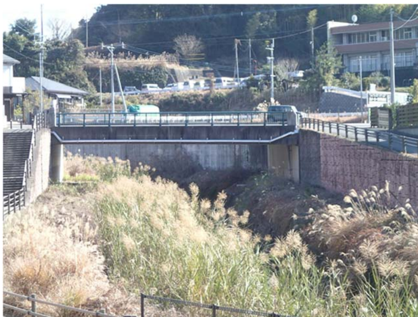
写真 6.6 対象橋梁の外観
