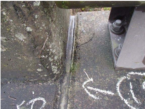
写真 6.20 地覆目地材(1期施工)
