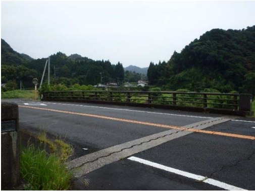
写真 6.16 橋軸直角方向伸縮装置(終点側)
