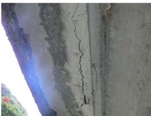
写真 6.22 雨水の侵入による損傷
