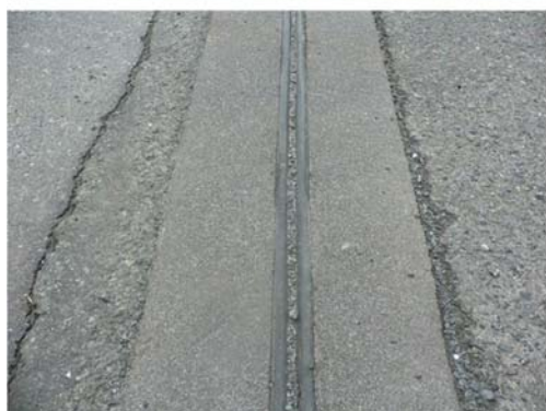
写真 6.22 雨水の侵入による損傷
