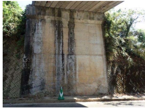
写真 2.4 内陸部 橋台の水掛かり部
