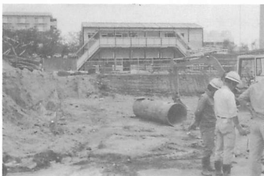
写真7 医学部中央診療棟新営工事に伴う立合調査風景
