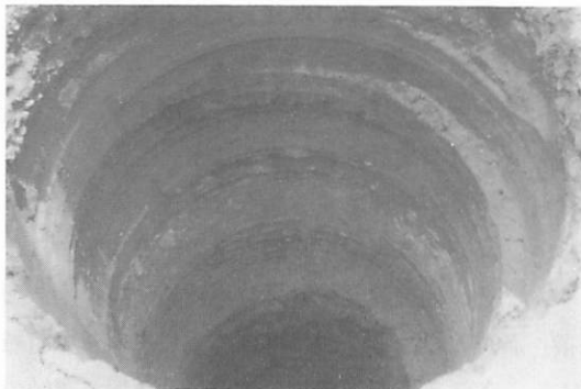
写真8 医学部中央診療棟新営工事に伴う立合調査（アースドリル掘削坑）
