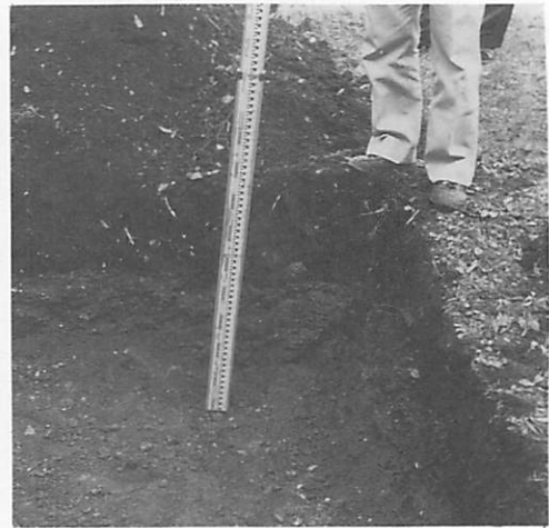
写真2. 胸像台座設置工事完掘状況
