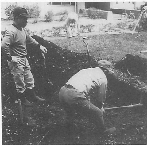
写真1. 胸像台座設置工事作業状況
