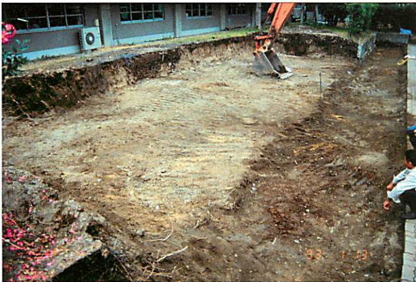
PL.9 A 地点表土掘削
