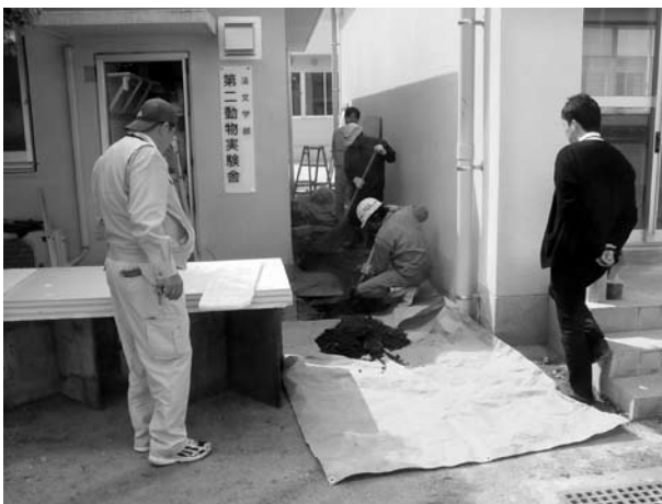
21 2008-L 掘削状況
