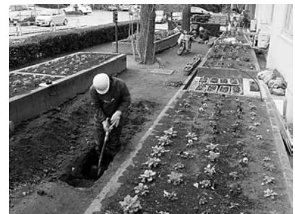
8 No.4・5 トレンチ掘削状況
