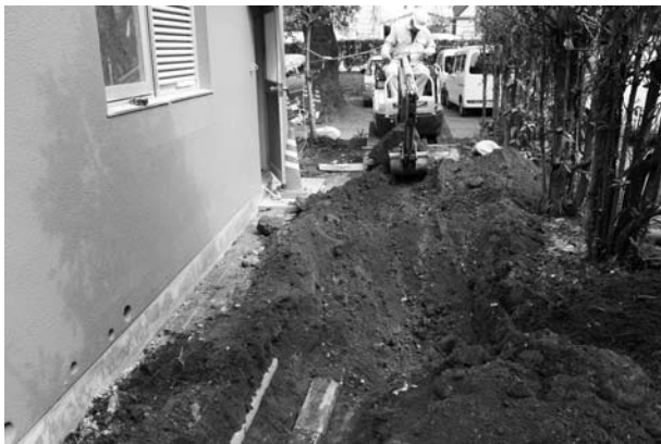
13 2008-F F12 付近掘削状況
