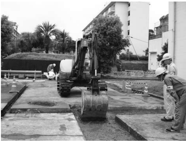
7 2008-D 掘削状況
