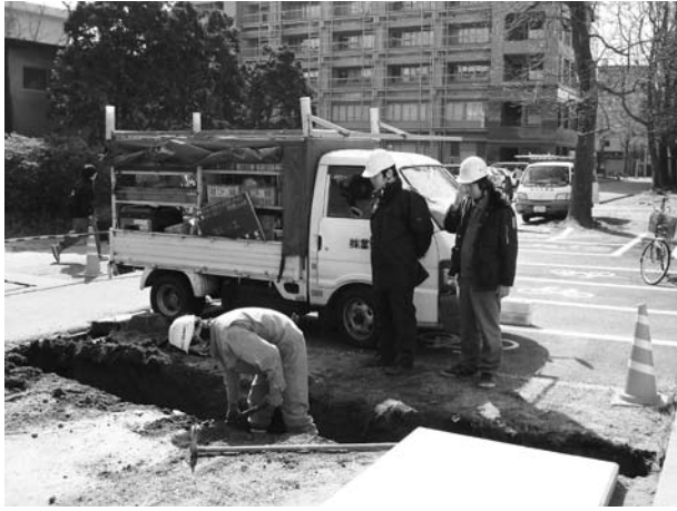
17 2008-K K1 掘削状況
