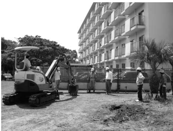
3 2008-B B2 地点掘削状況
