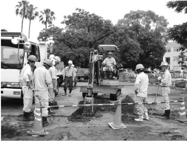
5 2008-C 掘削状況
