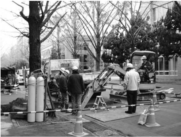
19 2008-K K2 地点掘削状況
