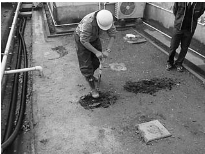
1 No.1 トレンチ掘削状況
