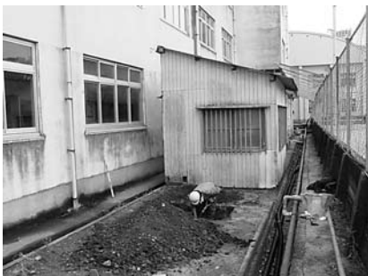
3 No.2 トレンチ掘削状況
