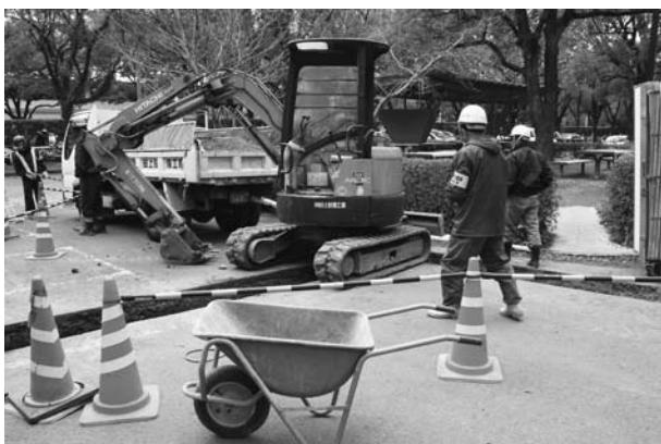
15 2008-F F14・15 付近掘削状況
