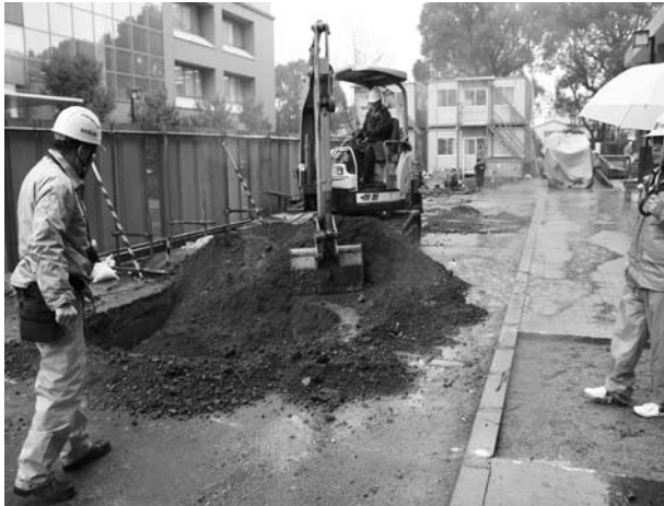
11 2008-F F10 付近掘削状況
