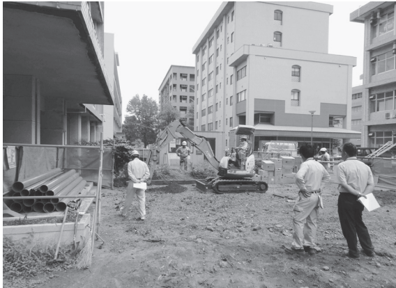
2012-C c 地点掘削状況
