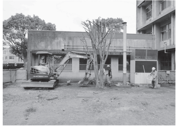
2012-C e地点掘削状況 東より
