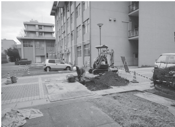
2012-I 9 地点掘削状況
