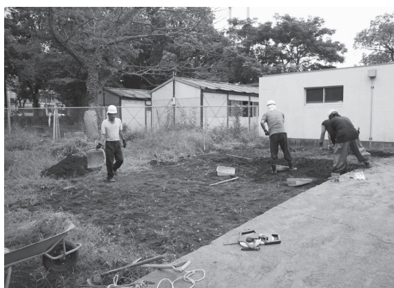
2012-2 掘削状況 南東から
