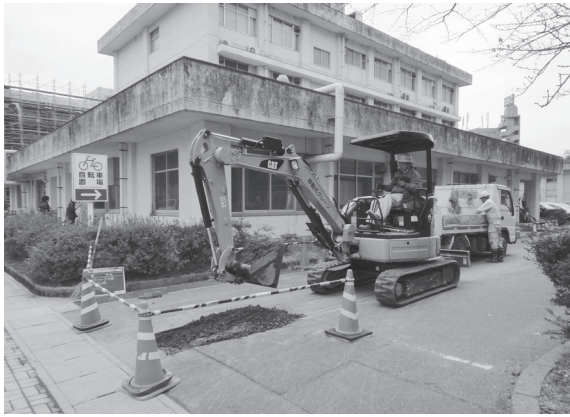
2012-I 8 地点掘削状況
