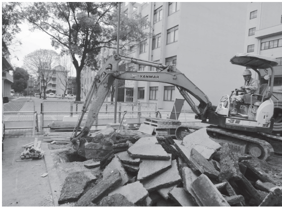
2012-I 5 地点掘削状況
