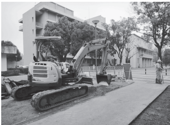
2012-J d 地点掘削状況
