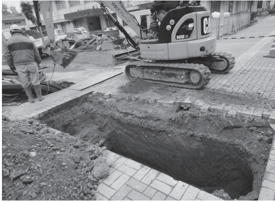
2012-I 4 地点掘削状況
