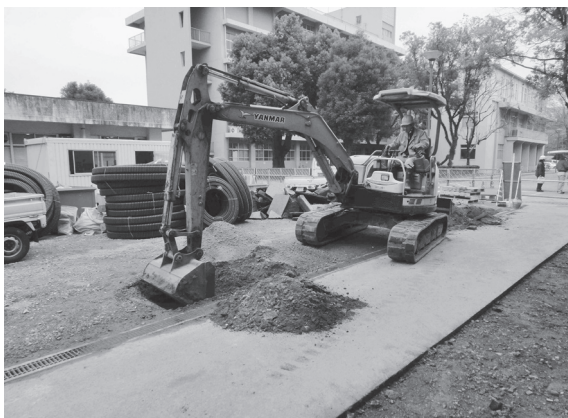
2012-J e 地点掘削状況
