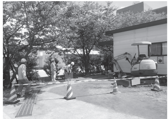
2012-E b 地点掘削状況
