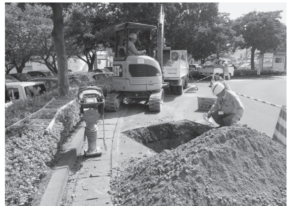
2012-E c 地点掘削状況
