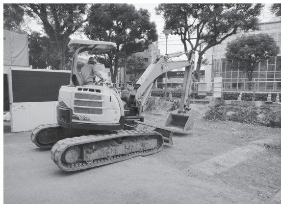
2012-J a 地点掘削状況
