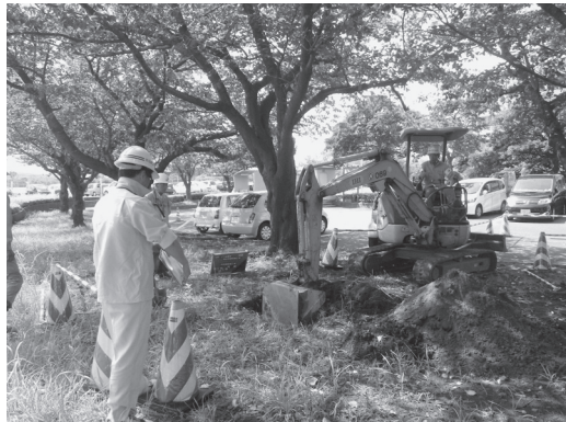
2012-E d 地点掘削状況
