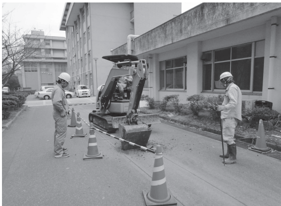
2012-I 7 地点掘削状況
