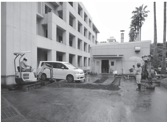
2012-D 掘削状況
