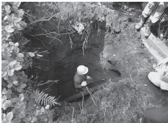
2012-B 東側掘削状況
