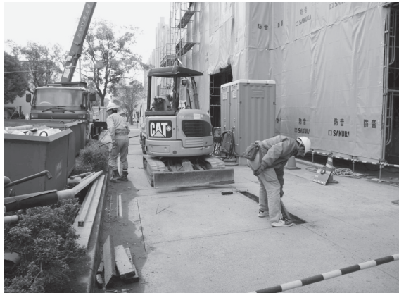
2012-I 2 地点掘削状況
