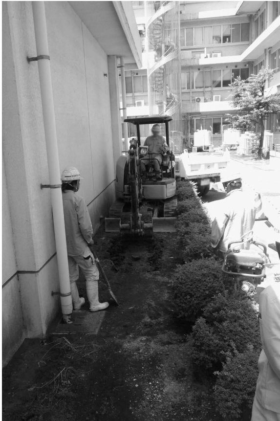
2012-E a 地点掘削状況
