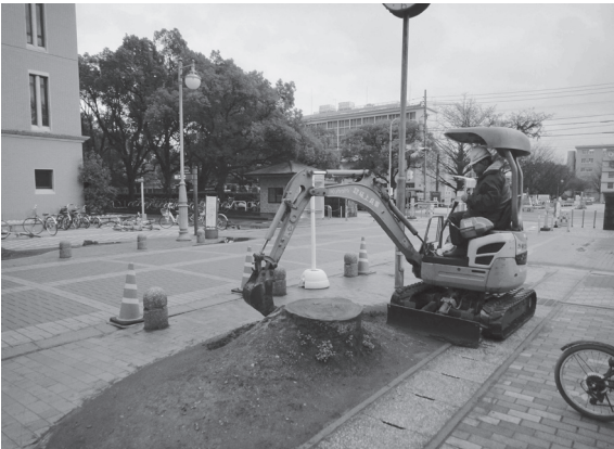
2012-G 掘削状況
