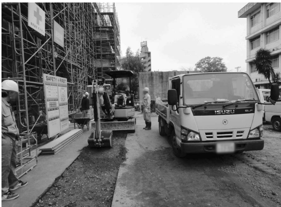
2012-I 3 地点掘削状況
