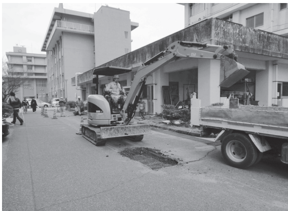
2012-I 6 地点掘削状況
