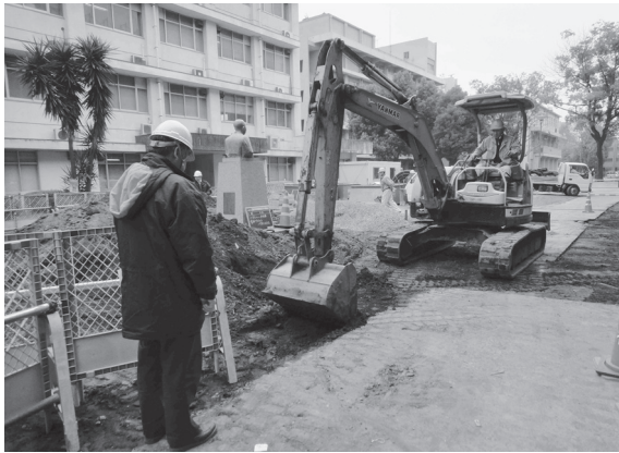
2012-J c 地点掘削状況
