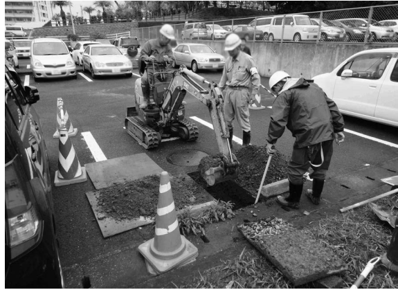
2012-A b地点 南東より
