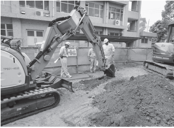
2012-C a 地点掘削状況 北東より
