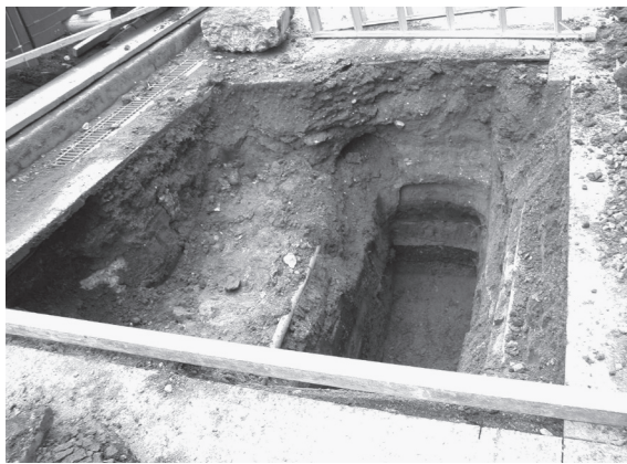
2012-I 2 地点掘削状況
