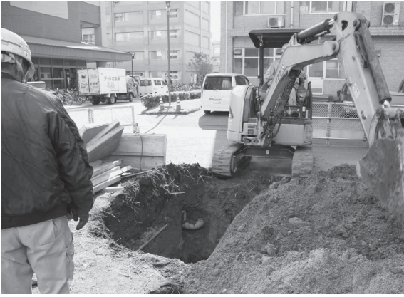
2012-I 1 地点掘削状況
