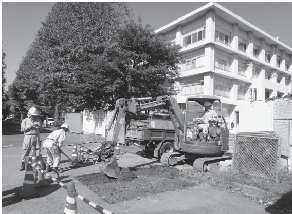
2014-H b地点掘削状況
