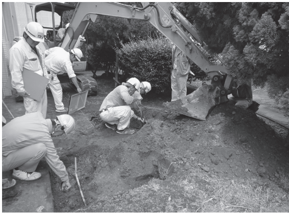
2014-G c地点 掘削状況
