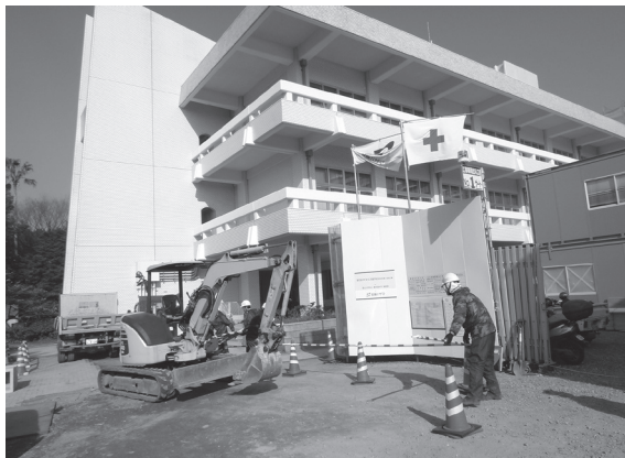
2014-G d地点 掘削地点
