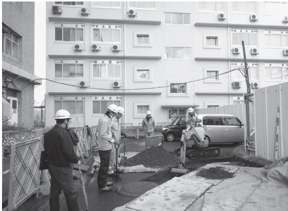
2014-B l地点 掘削状況
