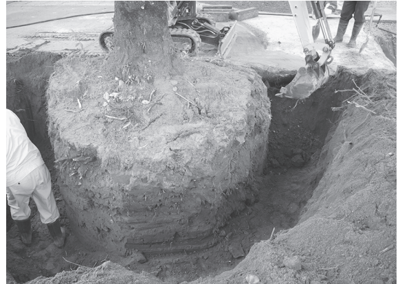
2014-D a地点 移植掘削作業 東から
