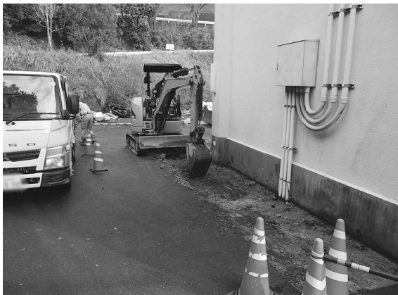
2014-M b 地点掘削地点
