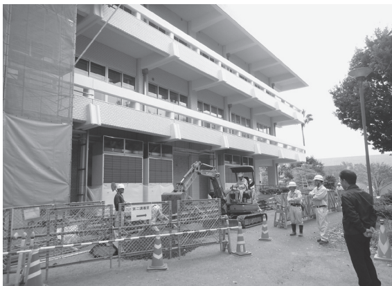
2014-L 掘削状況
