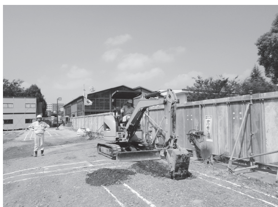
2014-B e地点掘削状況
