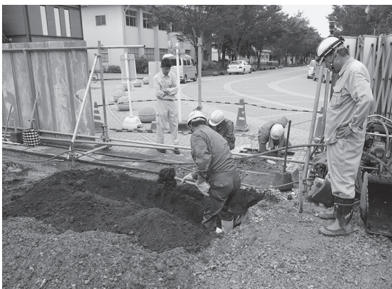
2014-B c地点 掘削状況
