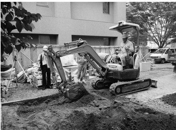
2014-C 東側電柱掘削状況
