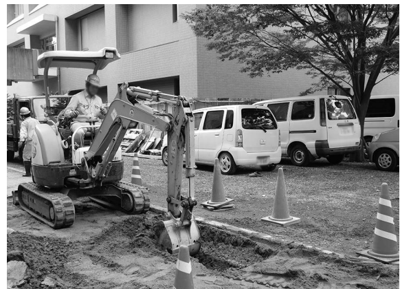
2014-C 西側電柱掘削状況
