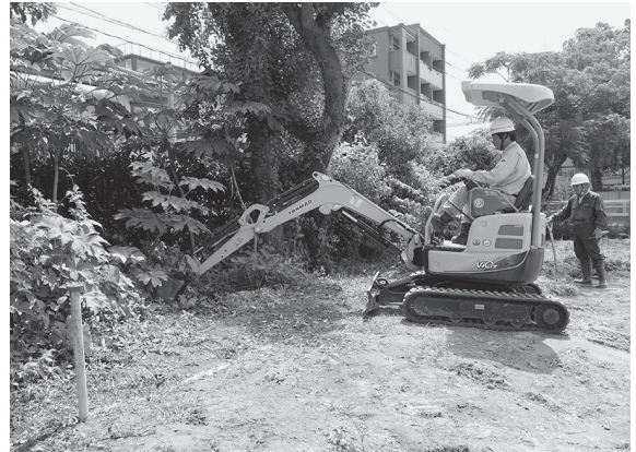
2014-D b地点 移植先掘削
