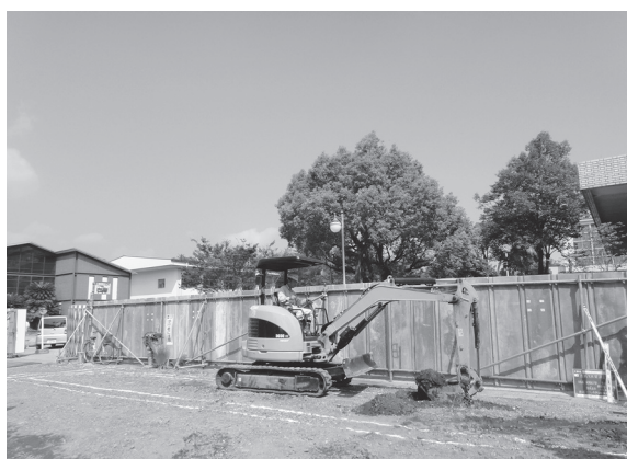
2014-B f地点掘削状況
