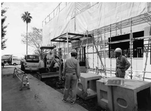
2014-B d地点掘削状況 北より
