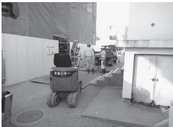
2014-F d地点掘削
