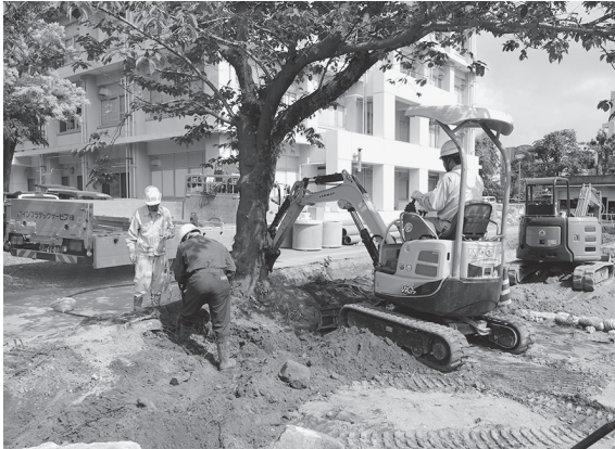
2014-D a地点 移植掘削作業開始 南西から
