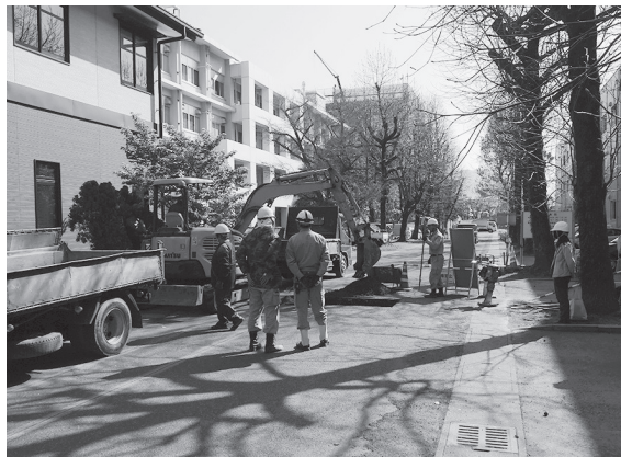
2014-H d地点 掘削地点
