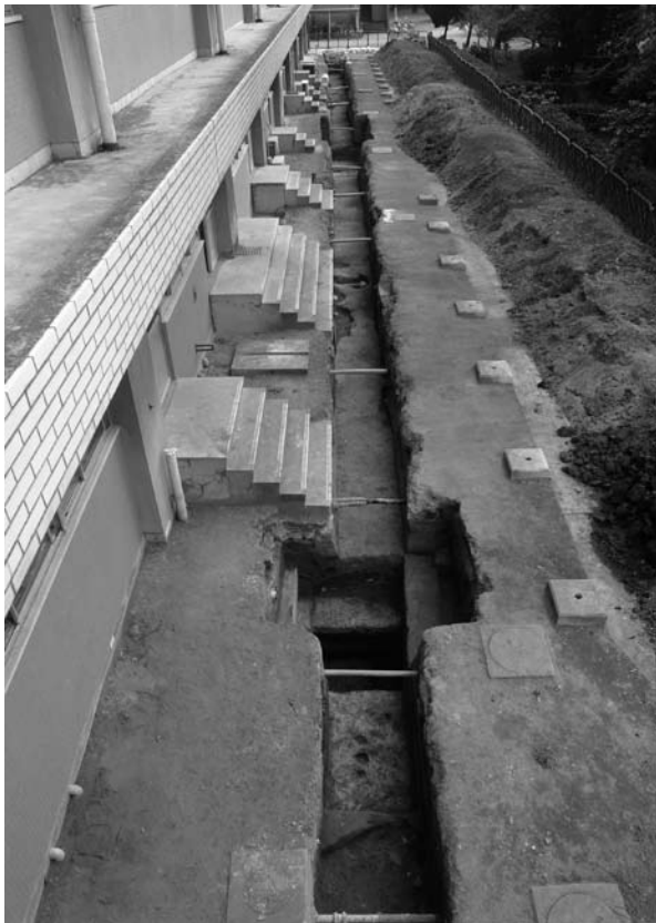
南区完掘(西より)
