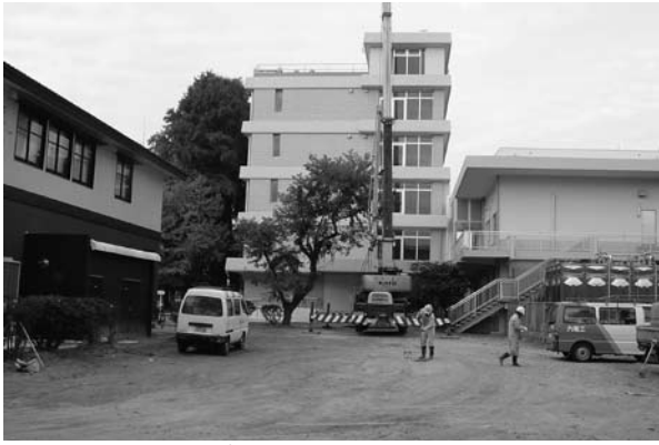
発掘調査前のボーリング調査(2007.11.26)
