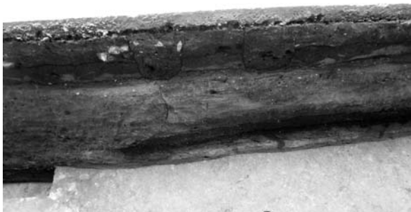
北壁 (SK1付近)
