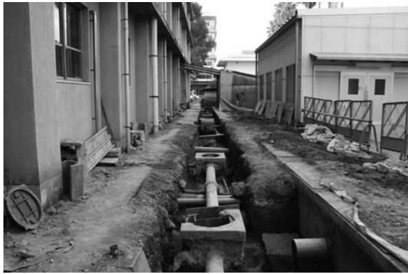
2区掘削[東より]
