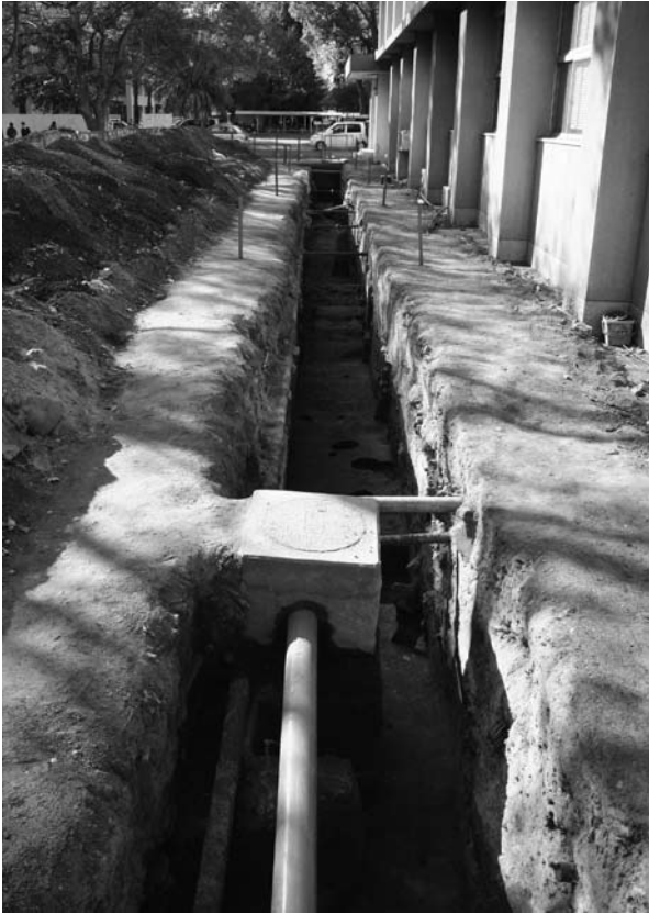
1区完掘[東より]
