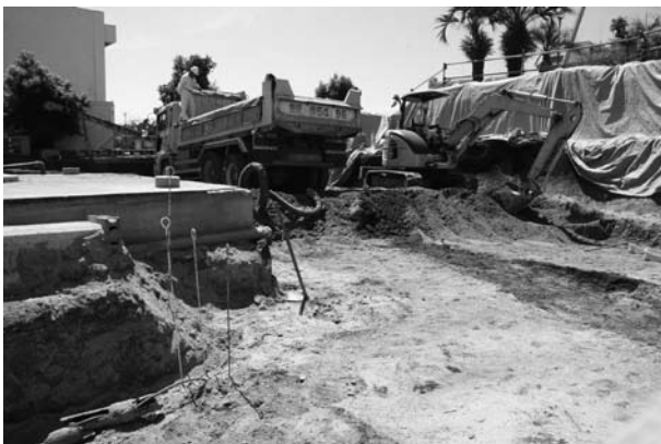
PL.35 6層土重機掘削状況 (西から)
