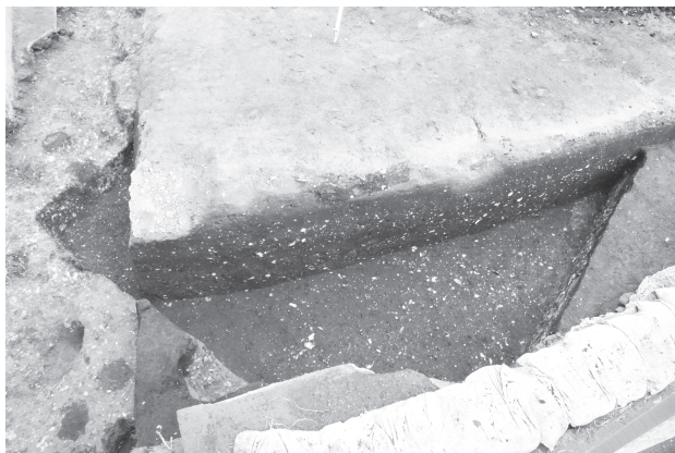
ルート 7b・c・SI02 掘削 (西より)
