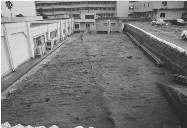
3層上面検出 北から
