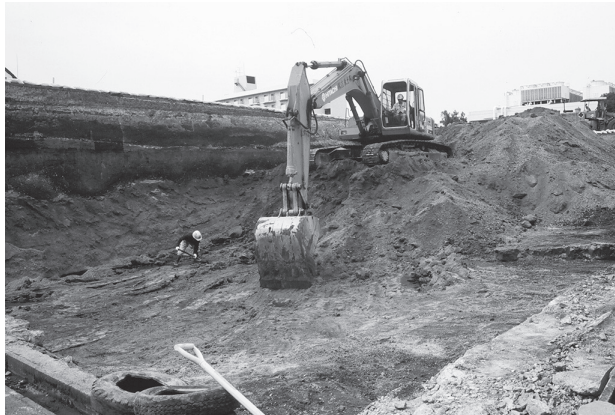
5層（薩摩火山灰層）除去作業
