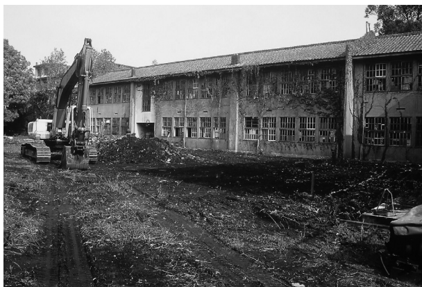
1 掘削開始前（南東から）
