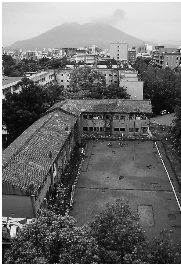
2 表土・2層掘削後（西から）
