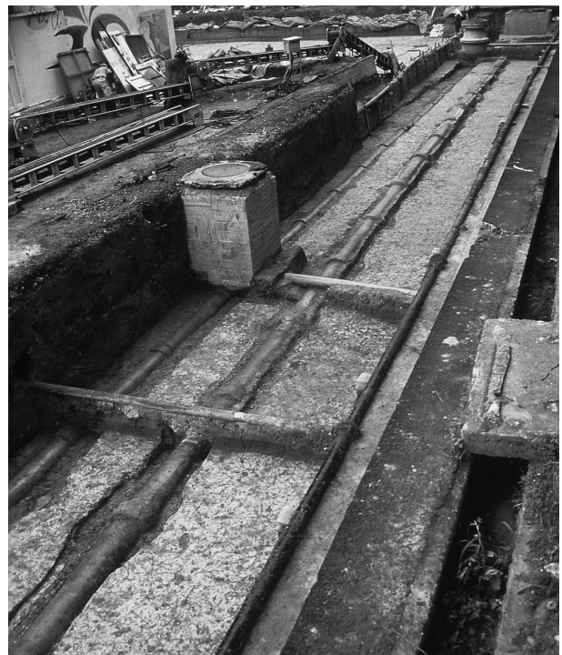
3 共同溝部全景 (北から)
