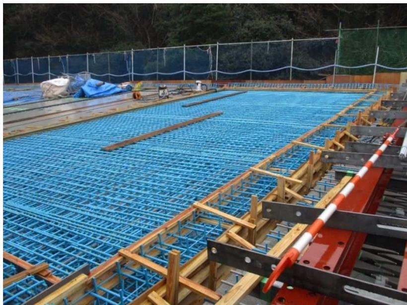
写真-1.1 橋梁床版部の配筋
