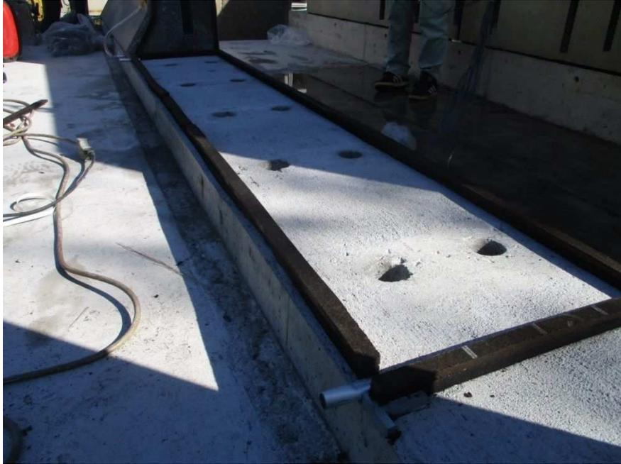
写真-5.18 バックアップ材としてエラストイトを貼付
