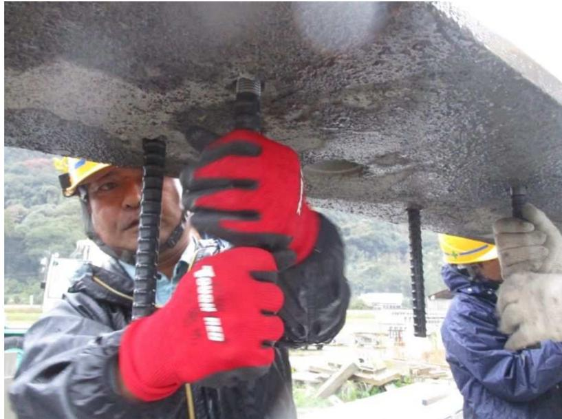
写真-5.23 底版部のアンカー筋の取付状況
