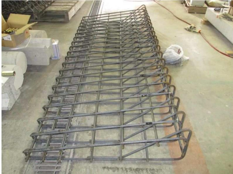
写真-5.4 プレキャスト壁高欄の配筋の状況
