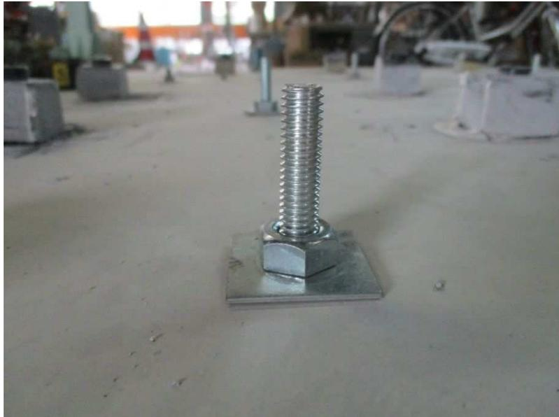
写真-3.3 全ネジボルトの設置状況
