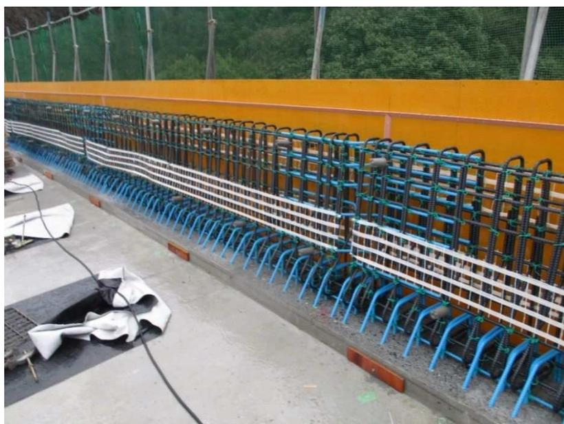
写真-1.2 橋梁壁高欄部の配筋
