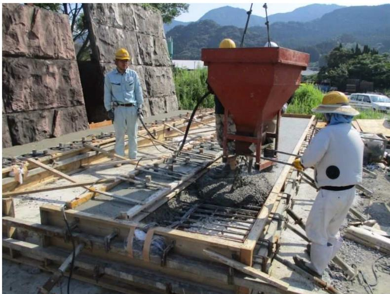
写真-5.15 基礎地覆部の製作状況（生コン打設）
