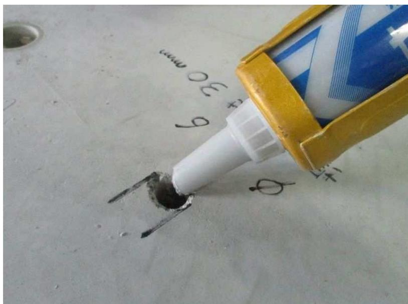
写真-3.2 充填材の注入状況
