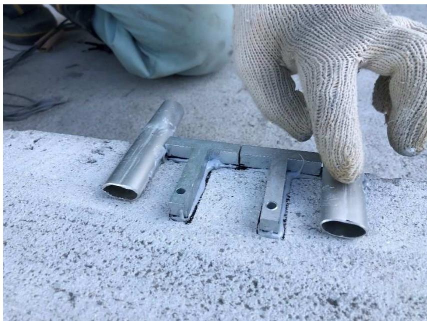
写真-5.17 スペーサおよび注入，排出口設置状況
