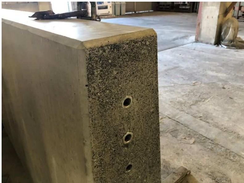
写真-5.13 小口面の粗面仕上げ状況
