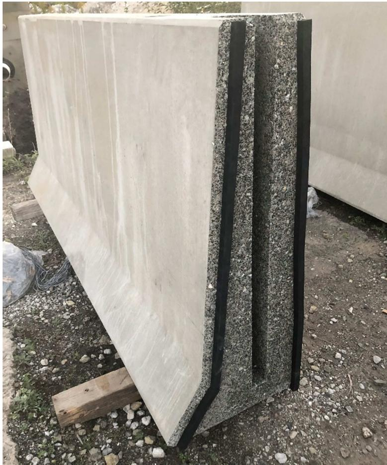
写真-5.20 側面部のバックアップ材の貼付け状況
