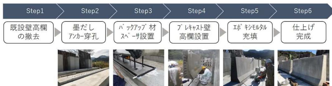
図-5.12 プレキャスト壁高欄の施工フロー
