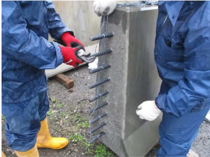
写真-5.21 側面部のアンカー筋（D22）の取付け状況
