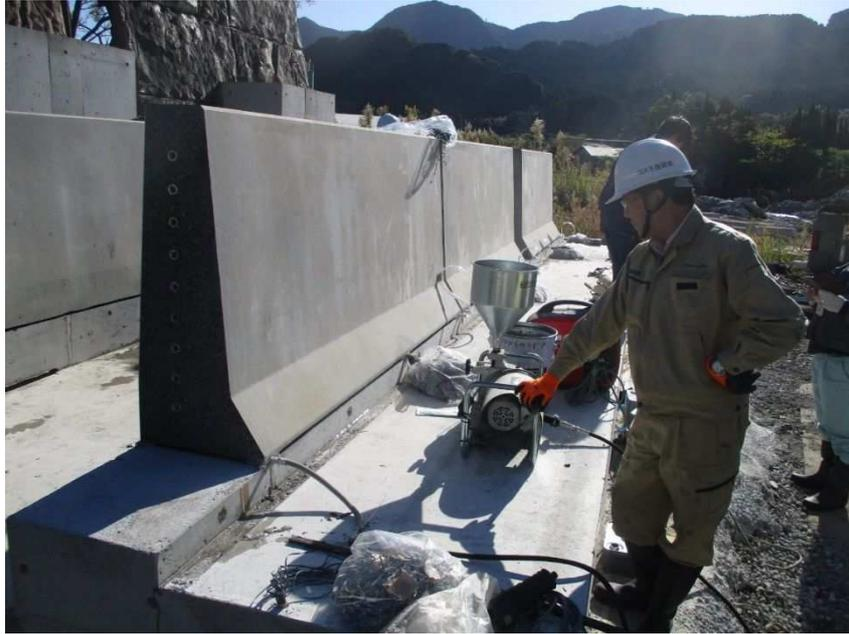
写真-5.28 エポキシモルタル充填作業状況
