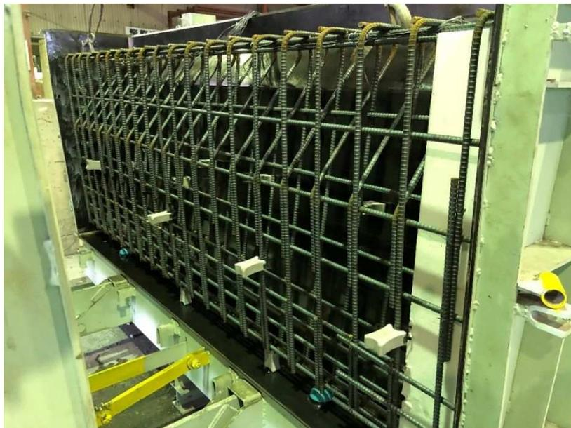
写真-5.7 横連結用のスリット部の発砲セット状況
