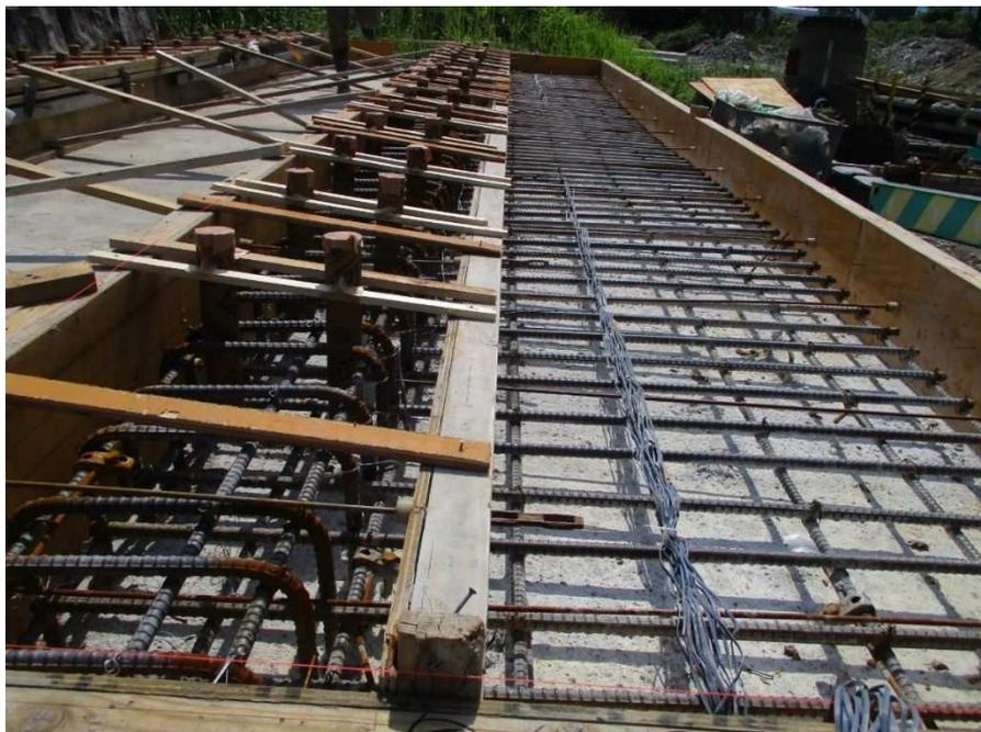
写真-5.14 基礎地覆部の製作状況（配筋）
