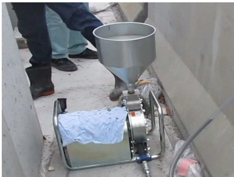
写真-5.27 充填作業に使用したスクイーズ式ポンプ
