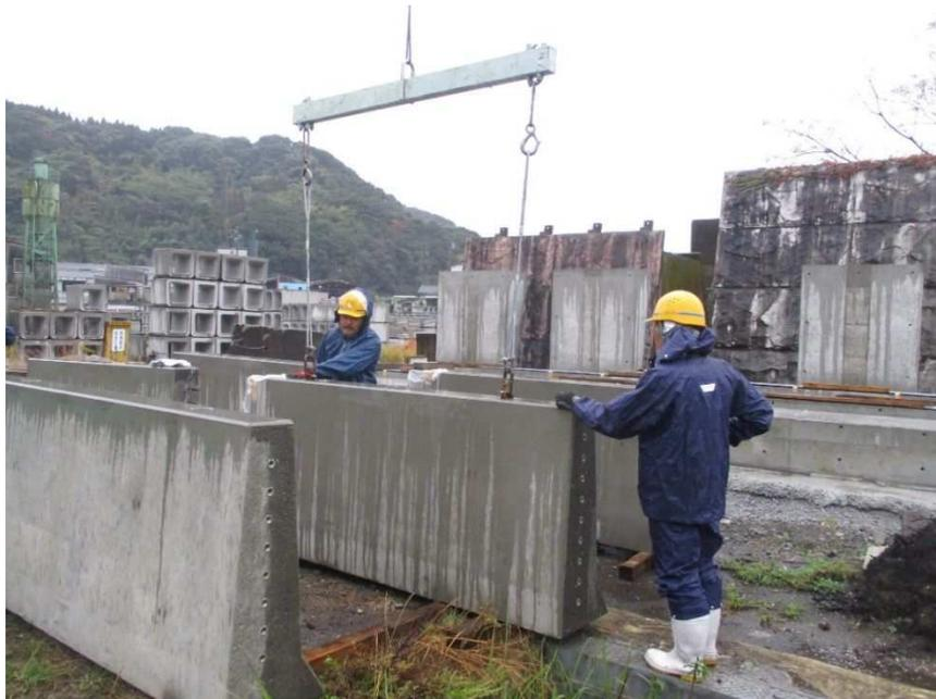
写真-5.22 製品の吊上げ状況
