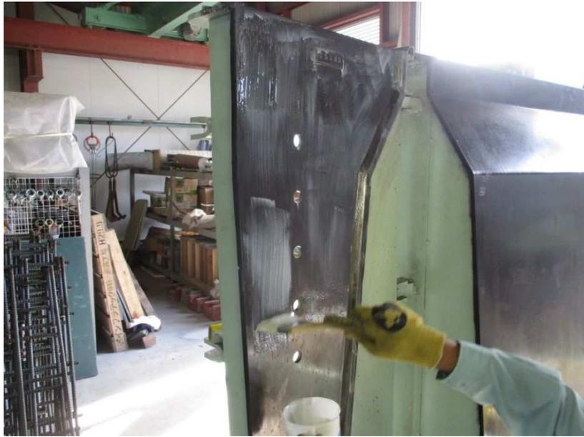
写真-5.8 連結部分に凝結遅延剤を塗布している状況
