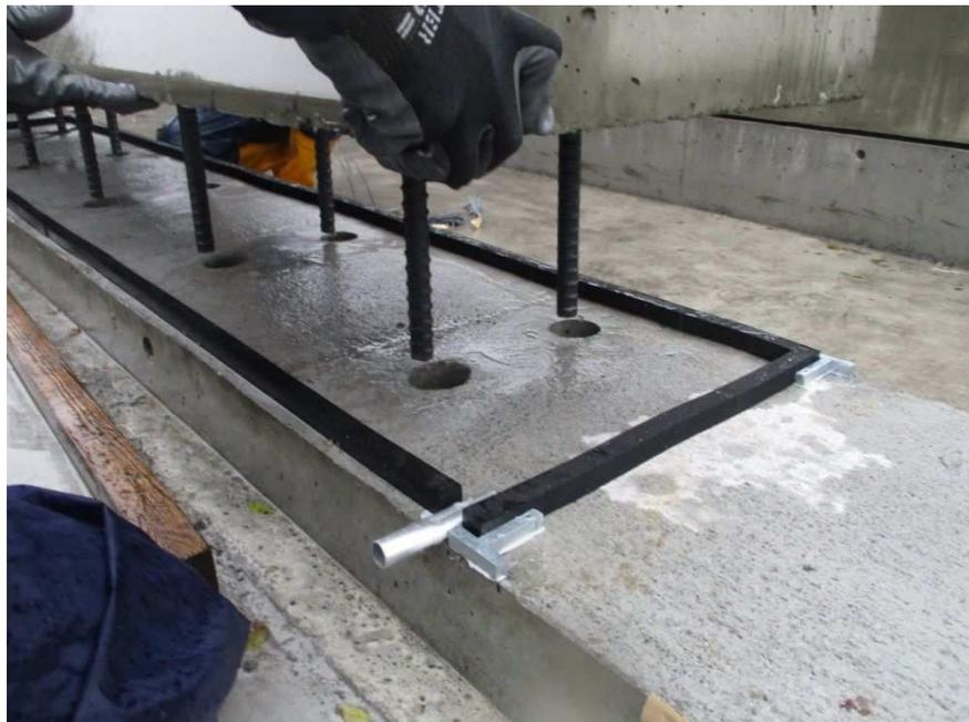
写真-5.19 バックアップ材としてスポンジゴムを貼付
