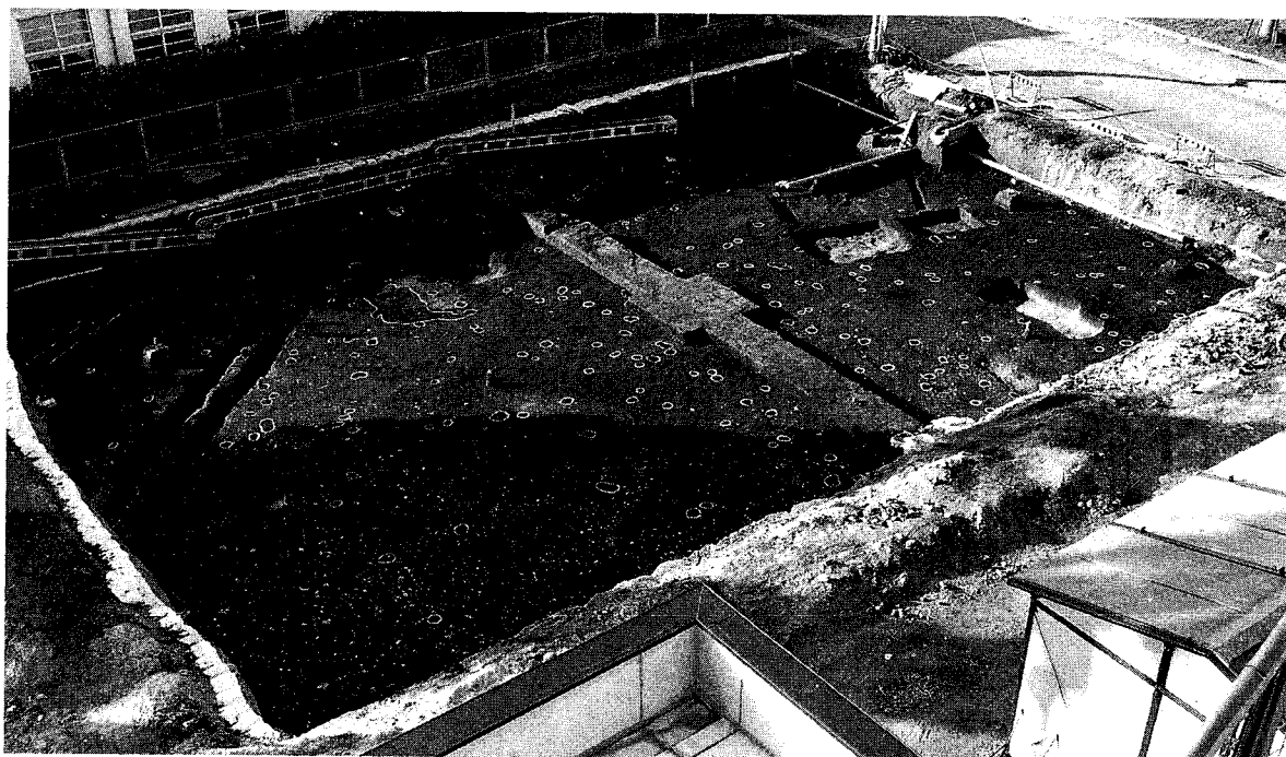
1. 7層上面遺構検出状況
