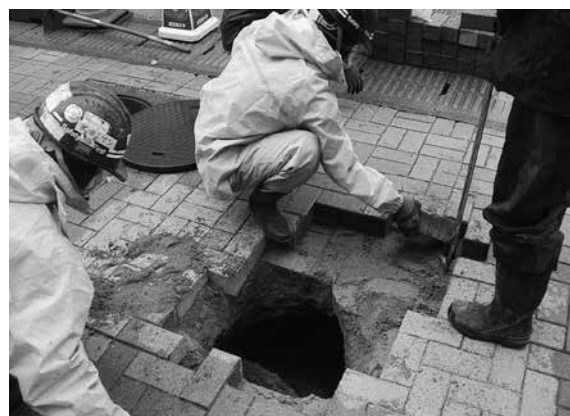
2016-L 掘削状況
