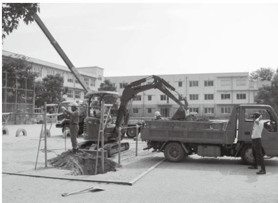
2016-B 掘削作業
