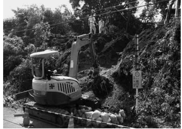
2016-A 崖面掘削作業
