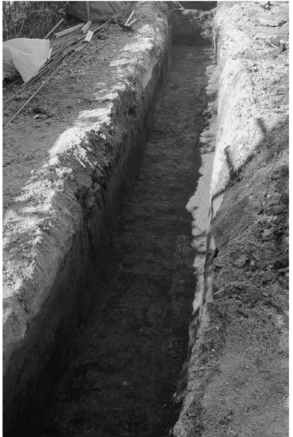
2016-G c 地点掘削状況
