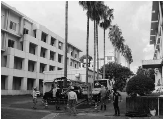
2016-C b地点 掘削状況
