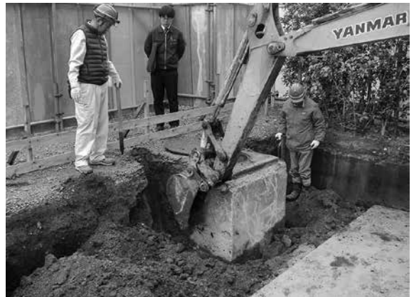
2016-G b 地点掘削状況
