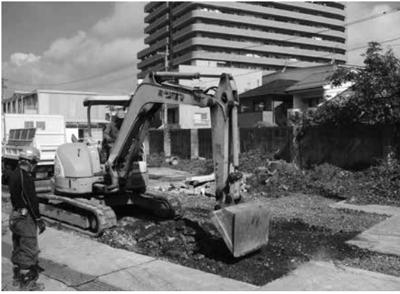
2016-C a地点 掘削状況
