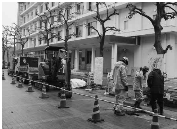
2016-L 掘削地点
