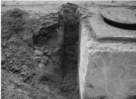
2016-G b 地点掘削状況
