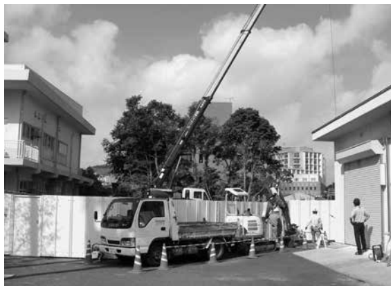
2016-C e地点 掘削状況
