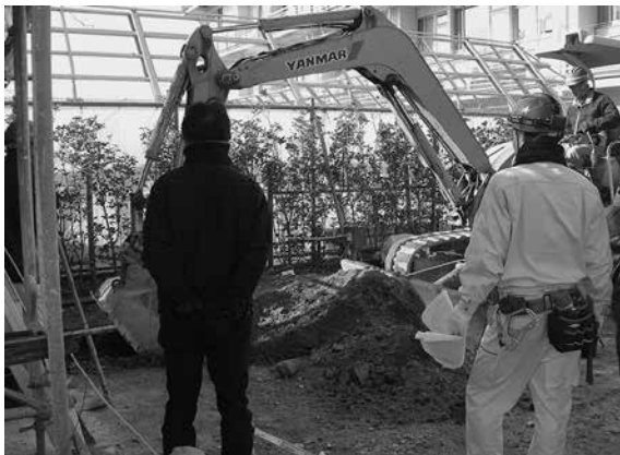
2016-G c 地点掘削状況
