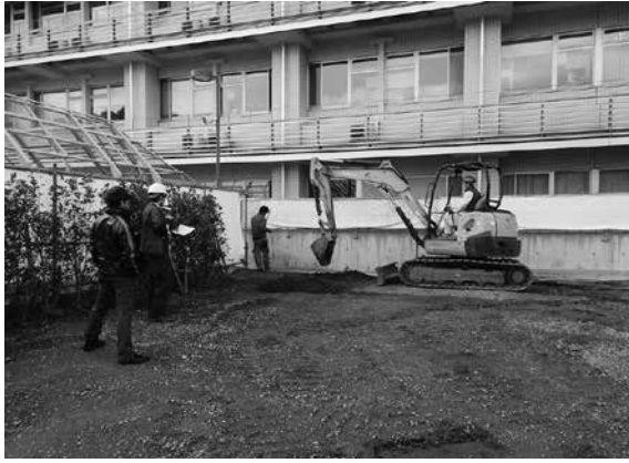
2016-G a 地点掘削状況
