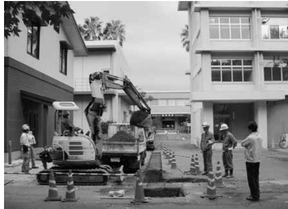
2016-C g地点 掘削状況
