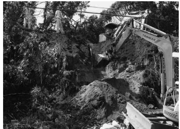
2016-A 崖面掘削作業
