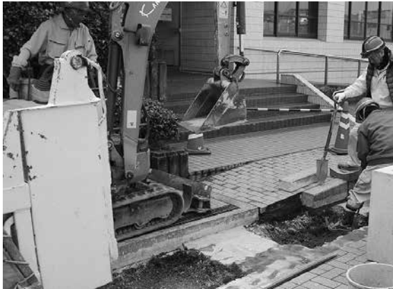
2016-F 掘削状況
