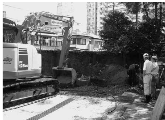
2016-D 掘削状況
