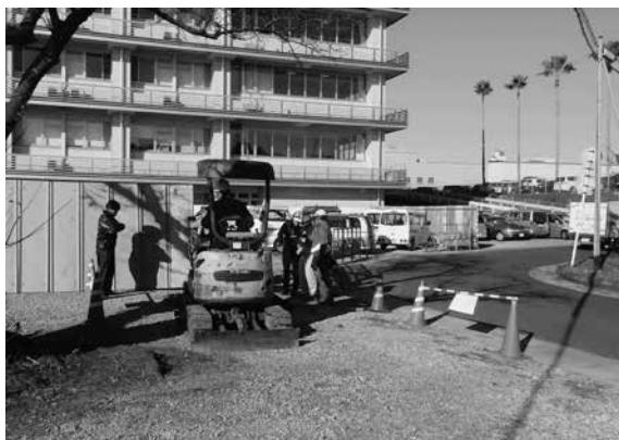
2016-E 掘削状況
