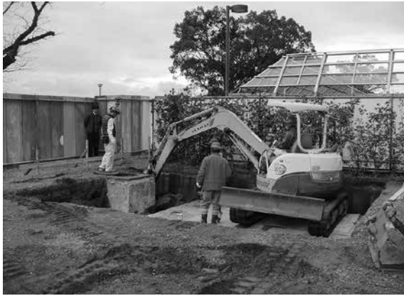
2016-G b 地点掘削状況
