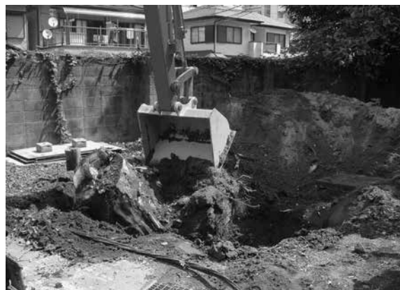
2016-D 掘削状況
