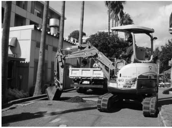
2016-C c地点 掘削状況
