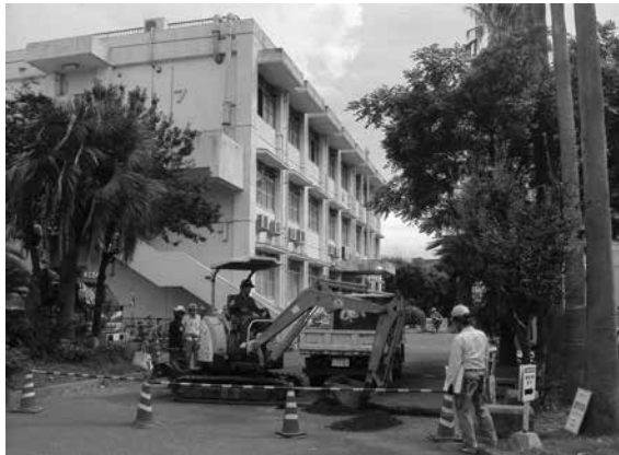
2016-C d地点 掘削状況
