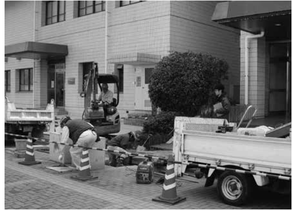
2016-F 掘削状況
