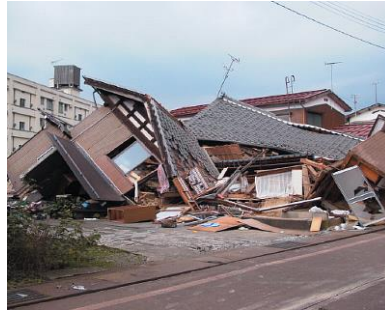
写真 1.5 新潟県中越地震の 被災家屋(2004年)
