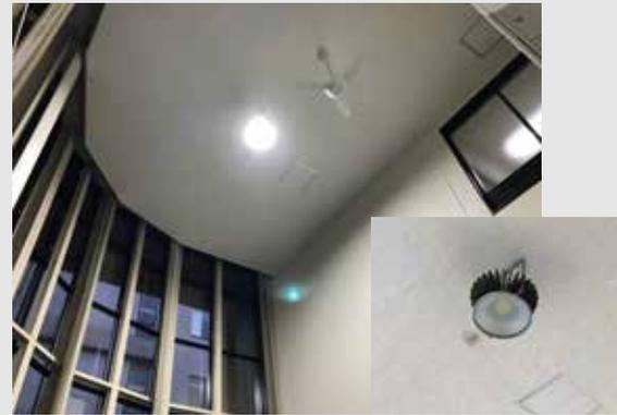
図 2-2-13 旧照明設備（水銀灯 4 灯+蛍光灯 12 本），新照明設備（FGHP ライト 1 灯）
