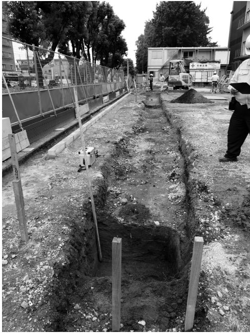
1 2019-D 掘削状況南から
