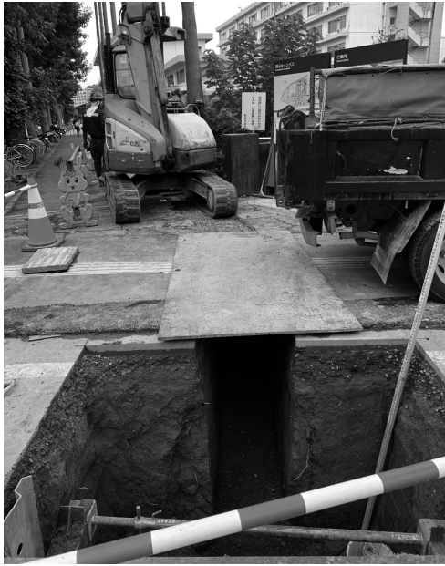
1 2019-B 掘削状況学外東側から
