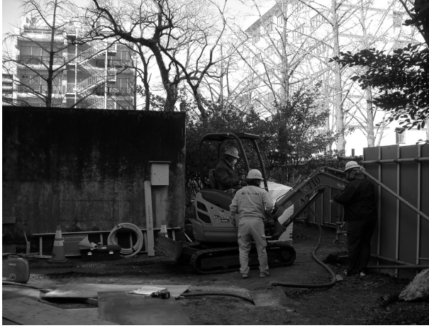
1 2019-M 掘削状況
