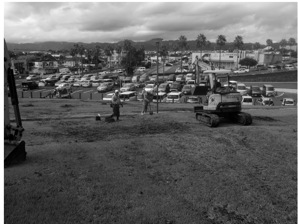
4 2019-C 樹木抜根掘削状況(北東から)
