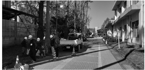
4 2019-Q 工事地点
