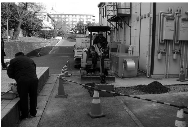
3 2019-P 掘削状況 (南から)
