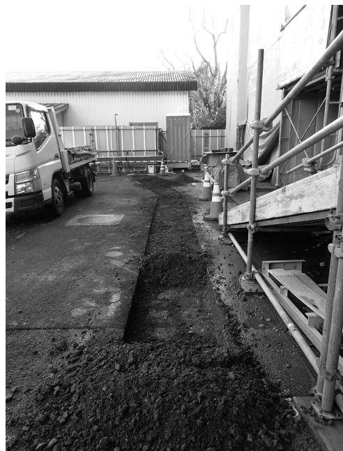
5 2019-H 工事掘削状況
