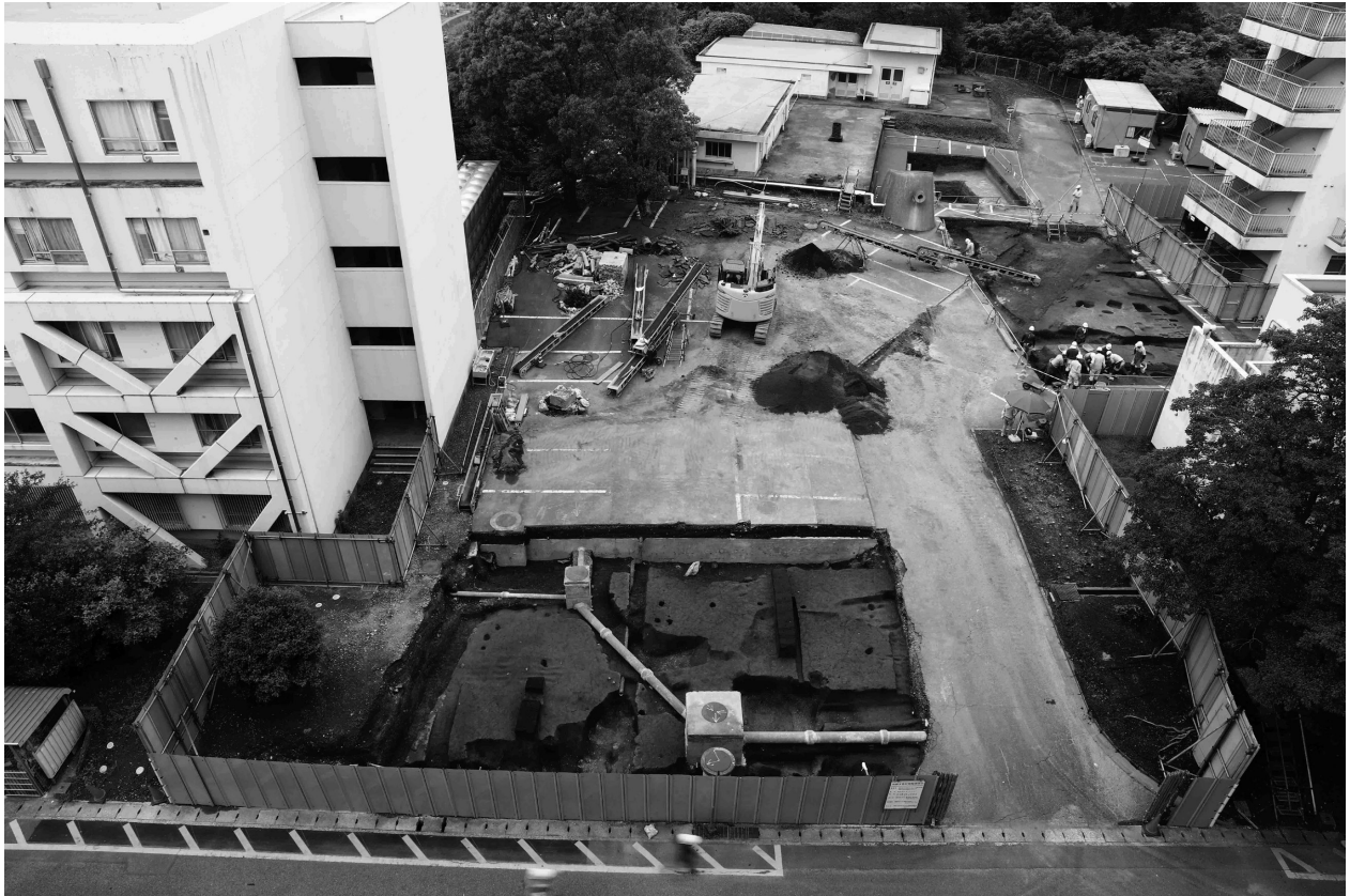
PL.1 2019-1 調査区全景 (B区未調査段階) (南より)
