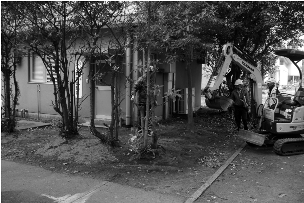
3 2019-L n地点付近掘削状況
