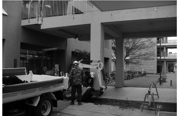
4 2019-L e地点付近掘削状況
