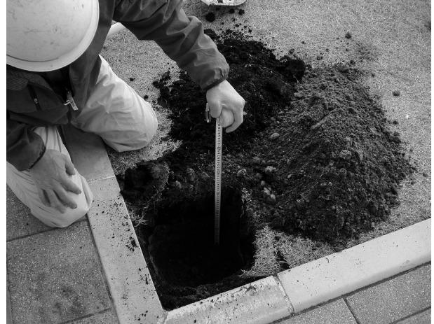
6 2019-N 掘削状況
