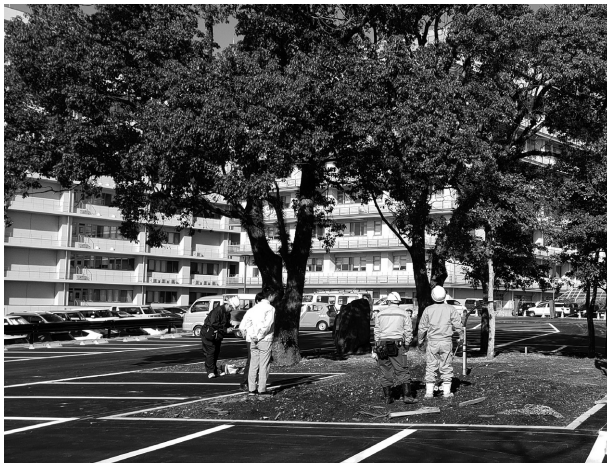
3 2019-C 外灯撤去掘削状況(南東から)
