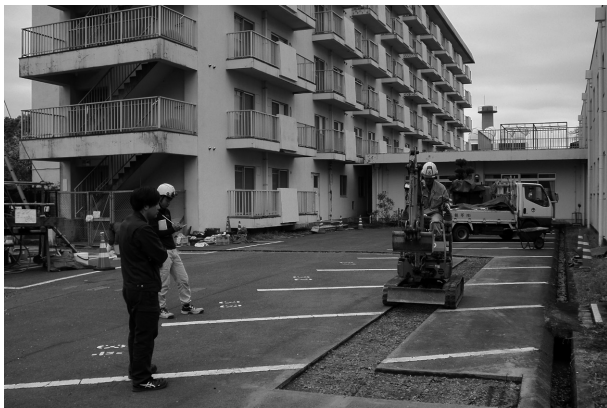
3 2019-A i・j地点ルート西から掘削状況
