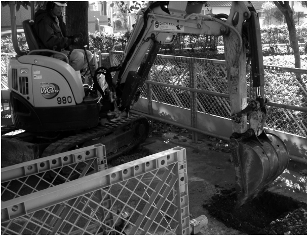
1 2019-K 掘削状況
