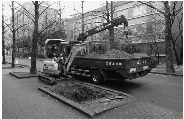
6 8トレンチ掘削(東から)
