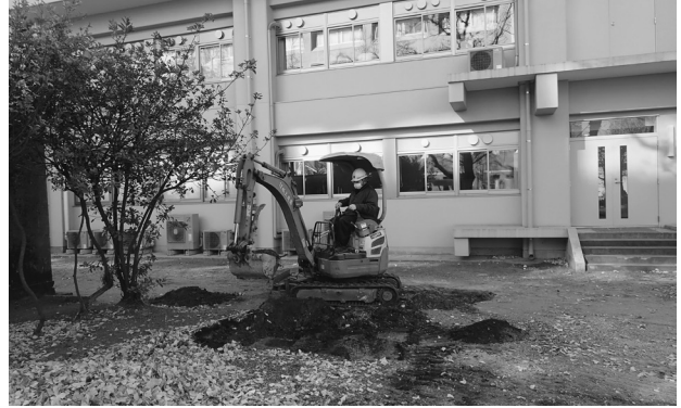
2 2トレンチ重機による表土掘削 (北から)
