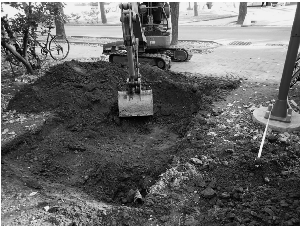
3 7トレンチ表土除去（南東から）
