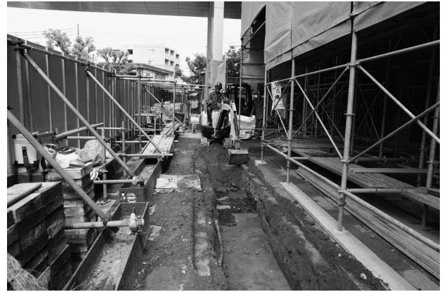
2 2・3区表土除去（西から）
