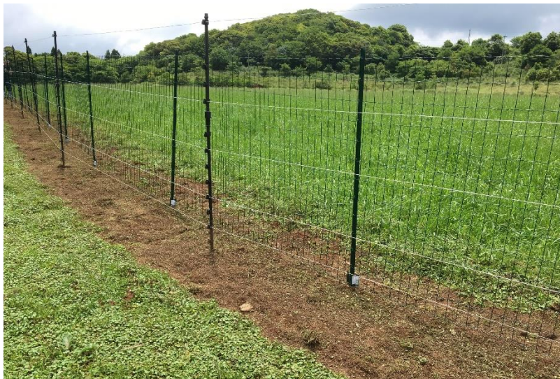
図 6-29. 電気柵と金属製ネット柵を併用したシカ侵入防止柵 (併用区)
